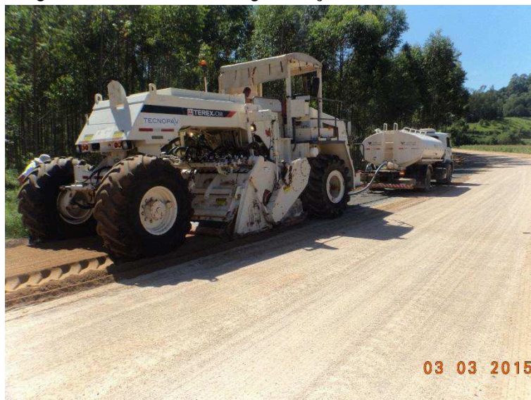
Figura 24 – Mistura e homogeneização entre solo e cimento
