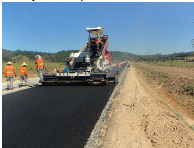
Figura 29 - Execução da camada de massa fina
