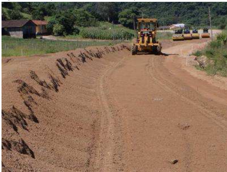
Figura 19 - Espalhamento do solo de jazida com motoniveladora
