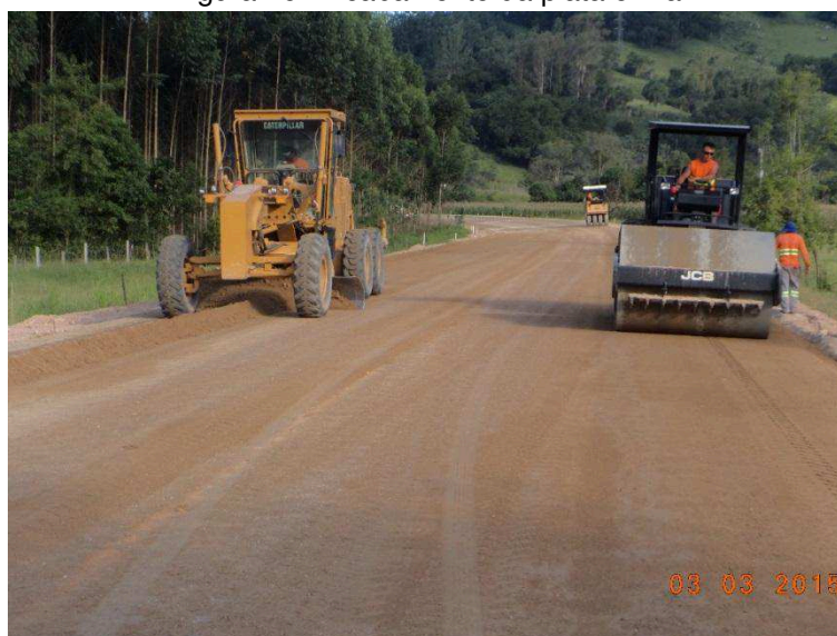
Figura 26 - Acabamento da plataforma
