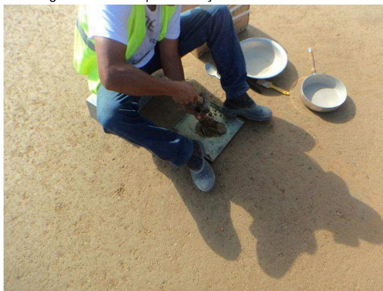
Figura 27 - Furos para medição da densidade in situ
