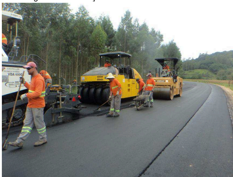
Figura 30 - Execução da camada de revestimento
