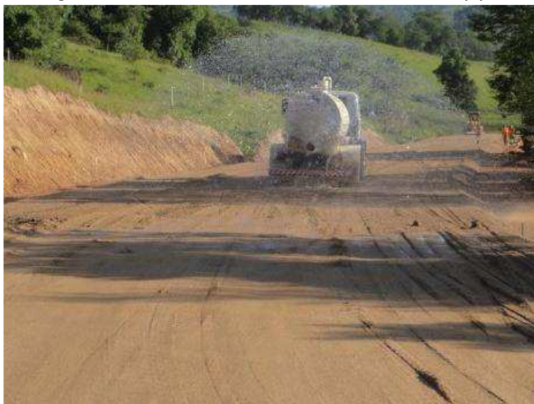
Figura 20 - Umedecimento do solo com caminhão pipa
