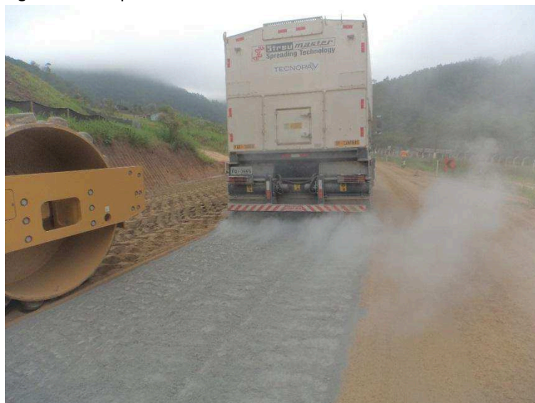
Figura 22 - Espalhamento do cimento com caminhão distribuidor
