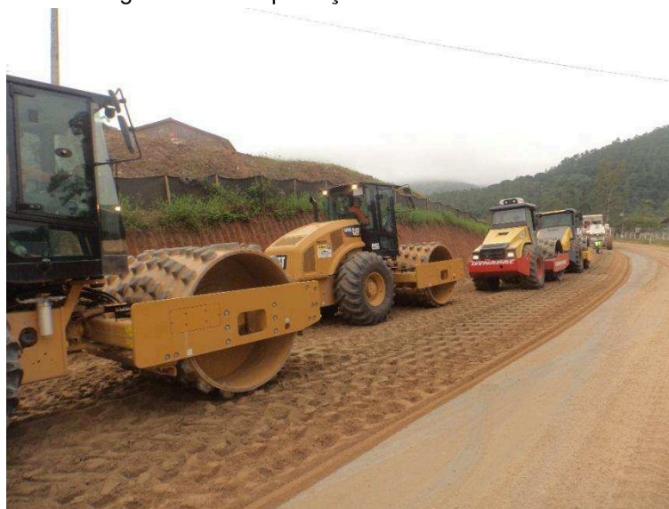
Figura 25 - Compactação da camada de base
