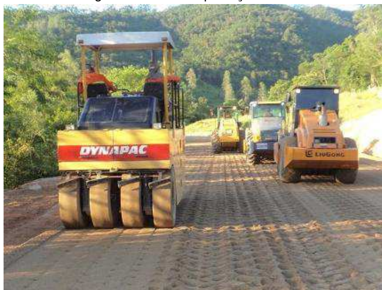
Figura 21 - Pré-compactação do solo
