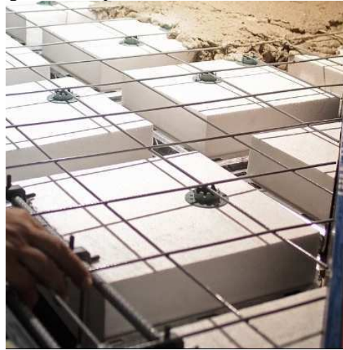
Figura 3 - Isopor (EPS) como material inerte
