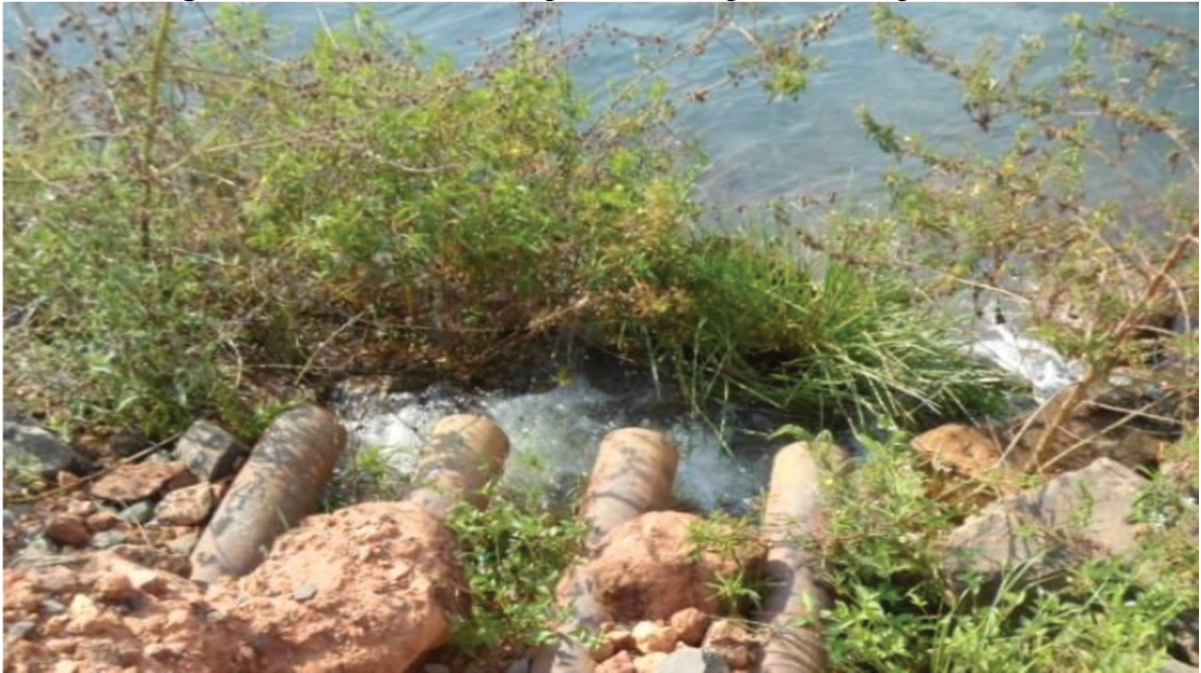
Figura 34 – Tubos de deságue da barragem na margem direita
