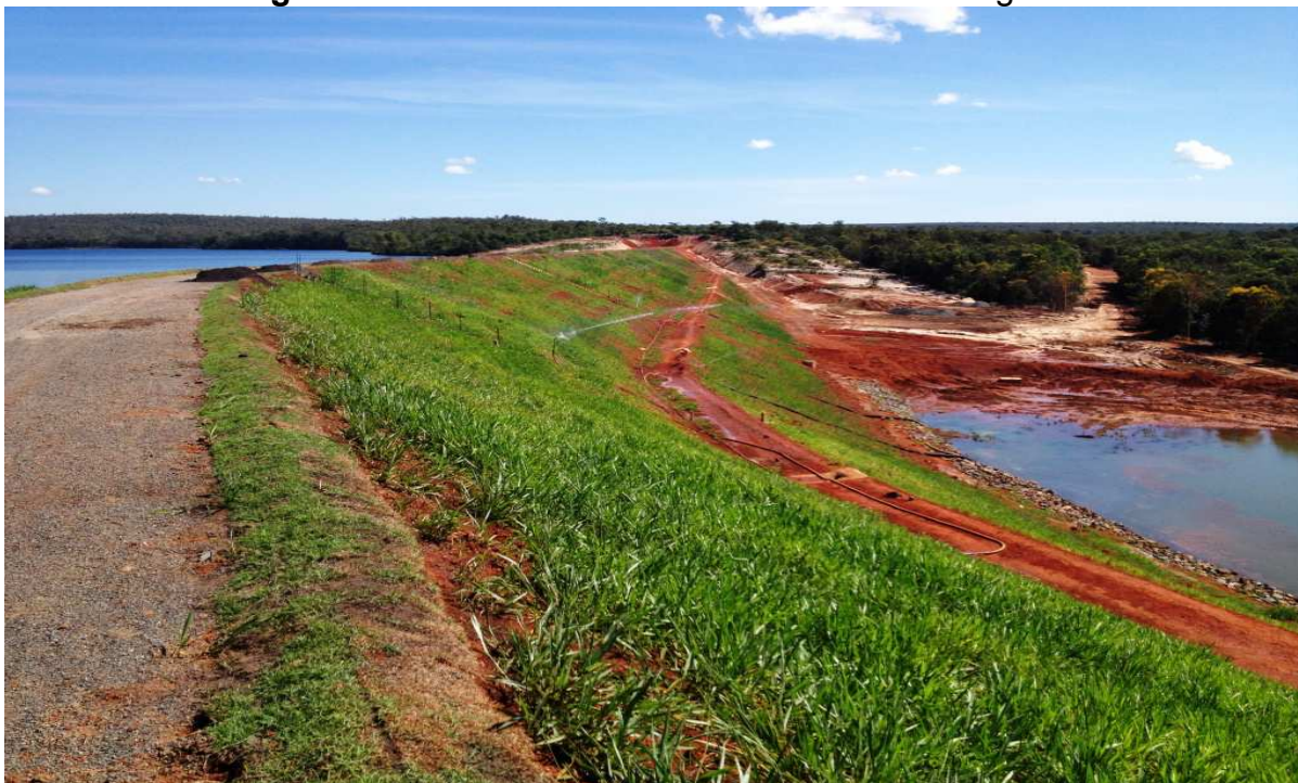
Figura 41 – Talude de Jusante com cobertura vegetal.
