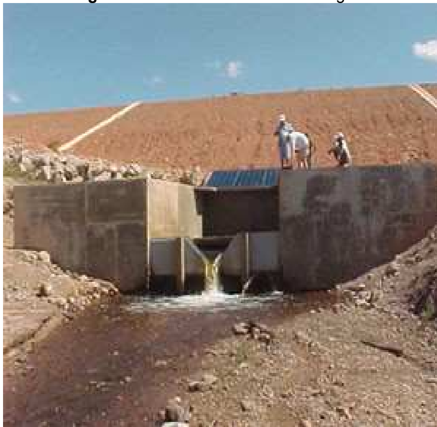
Figura 18 – Medidor de Vazão Triangular
