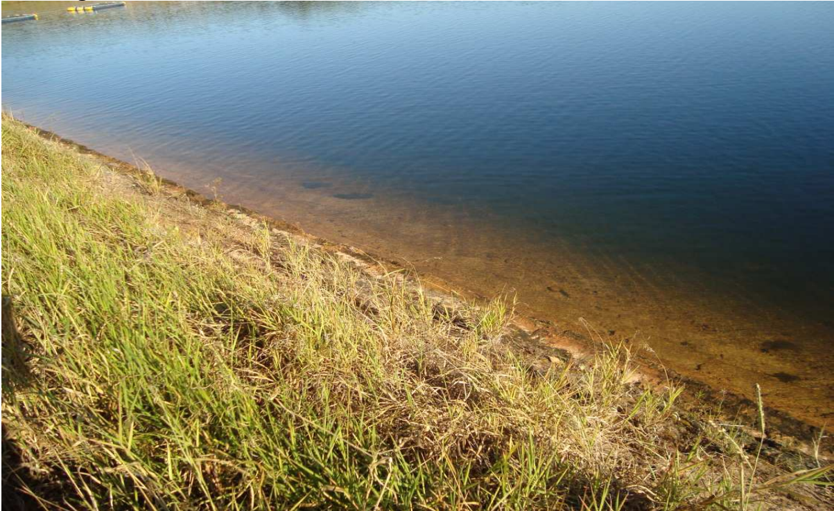
Figura 40 – Detalhe do talude de montante com o solo-cimento submerso
