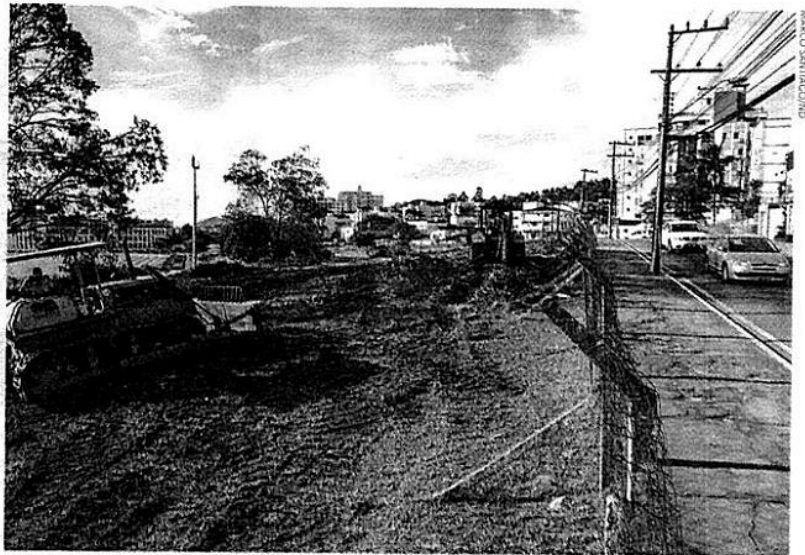
Obra saiu do papel. Duplicação da rua Edu Vieira começou ontem com corte de árvores, drenagem e marcação de pista
