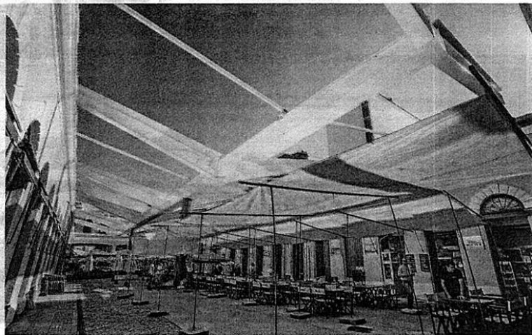
Polêmica. Estrutura metálica mudou o visual do vão central
