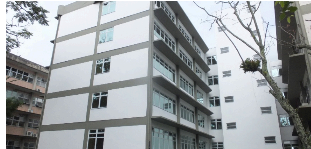
A primeira etapa da obra do prédio do Instituto de Engenharia de Superfícies do Departamento de Engenharia Mecânica do Centro Tecnológico, financiada com recursos CT-INFRA/FINEP e da UFSC foi concluída em janeiro de 2013. A obra foi retomada em março de 2016 e será um dos laboratórios multi-usuários mais bem estruturados do país. Crédito: Jair Quint/Agecom/DGC/UFSC
