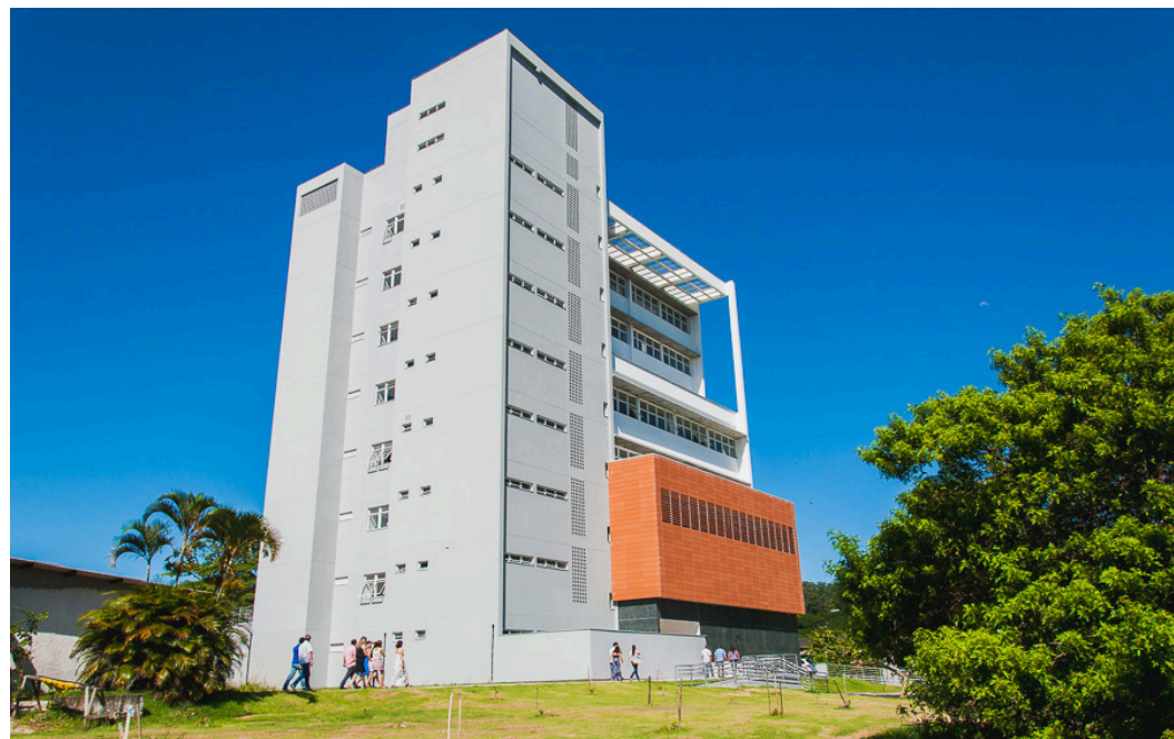
O novo bloco D do Centro de Comunicação e Expressão (CCE) da UFSC possui oito andares para abrigar salas de aula e laboratórios dos cursos de Artes Cênicas, Cinema e Design. Crédito: Pipo Quint/Agecom/DGC/UFSC
