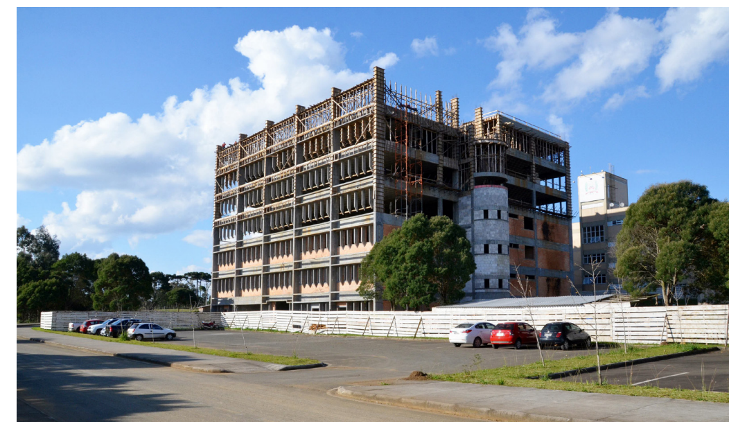
O Bloco CBS02 de Salas de Aula e Laboratórios é uma das maiores obras em andamento na UFSC. Iniciada em janeiro de 2015, a previsão é que seja finalizada no segundo semestre de 2016. O prédio possui 9.257,94 m 2 e o investimento é de mais de R$ 22 milhões. Crédito: Gabriel Olivo / UFSC Curitibanos
