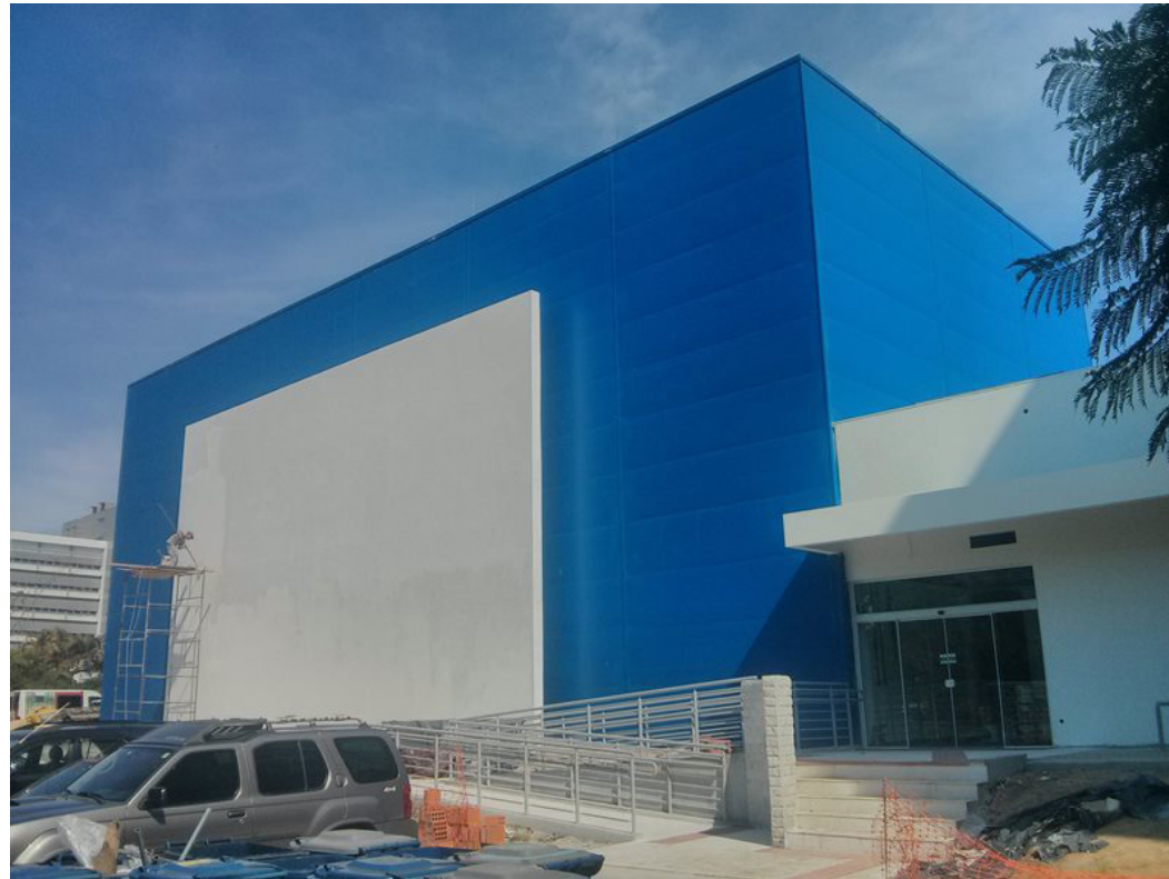
O Laboratório Tecmídia, do Centro de Comunicação e Expressão (CCE) tem quase 80% de sua construção concluída e abrigará uma estrutura de equipamentos de última geração, similares aos utilizados nas grandes produções de cinema internacional. Crédito: DFO/PROPLAN/UFSC
