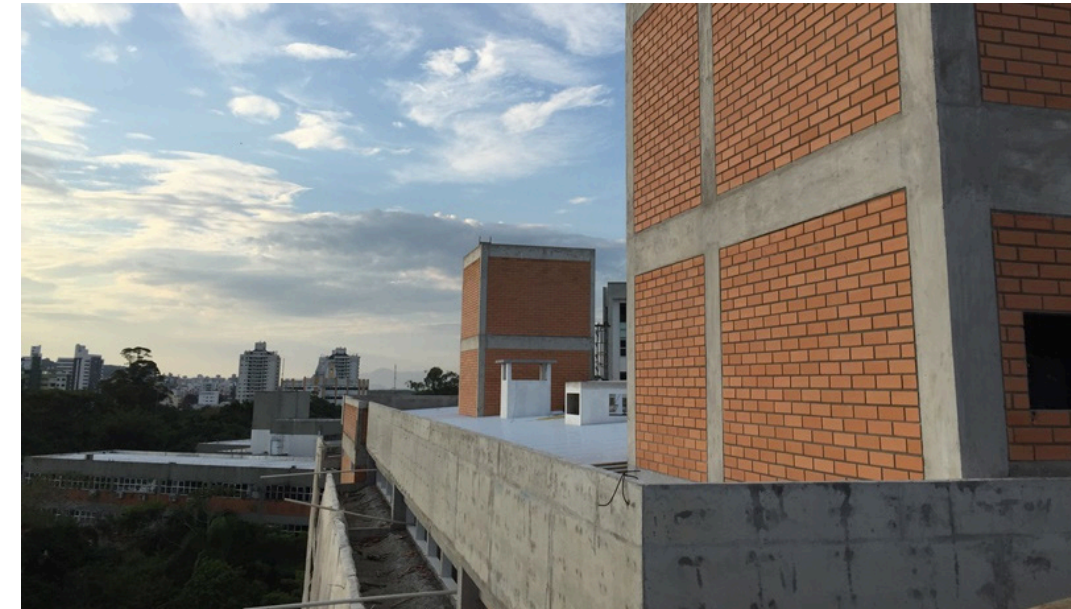
A ampliação do Bloco A do prédio da Engenharia de Química e Engenharia de Alimentos (CTC-EQA) tem 50% de sua construção concluída. Crédito: DFO/PROPLAN/UFSC
