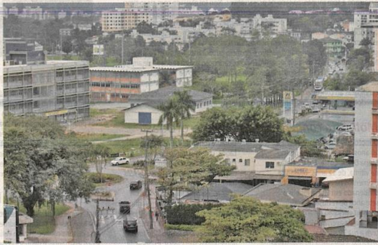
Gargalo. Obra de duplicação da rua Antônio Edu Vieira, que faz parte do anel viário, deve começar ainda em maio
