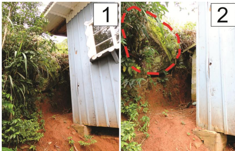
Figura 54: (1) Vista da parte detrás da casa; (2) vista do bloco em realce.
