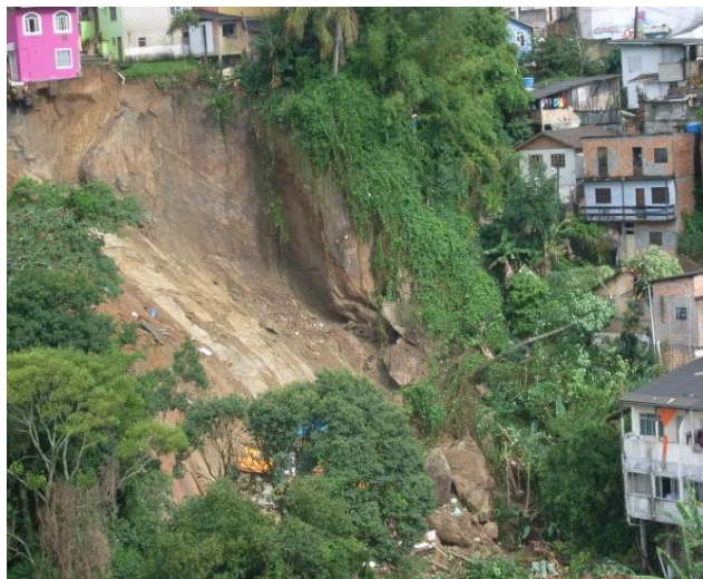
Figura 26: Vista da “rampa” formada após o movimento de massa. Foto: Foto: Luciano Augusto Henning.
