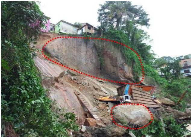
Figura 35: Vista geral do talude com dois blocos que sofrem decomposição esferoidal.
