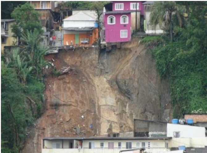
Figura 28: Vista das casas que foram descalçadas após o deslizamento. Foto: Luciano Augusto Henning.
