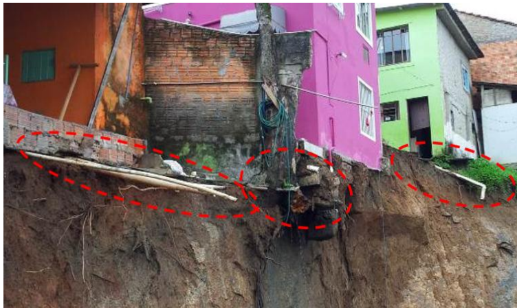
Figura 44: Vista de uma grande quantidade de tubulações de água, de esgoto e calhas de chuvas.
