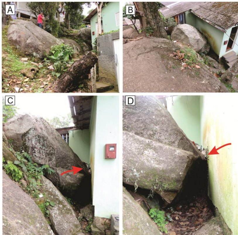
Figura 57: (a) Vista geral do afloramento; (b) vista geral do bloco; (c) vista do bloco; (d) detalhe da rocha encostada na moradia.
