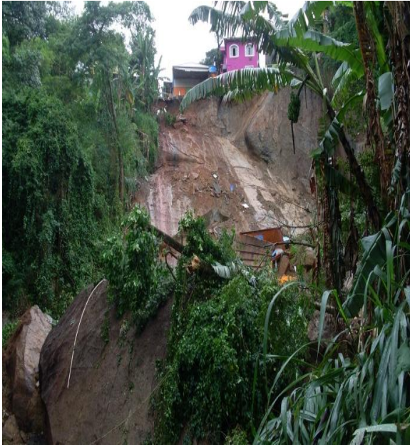
Figura 27: Vista geral do afloramento, evidenciando inclusive bananeiras na base do escorregamento. Foto: Luciano Augusto Henning.
