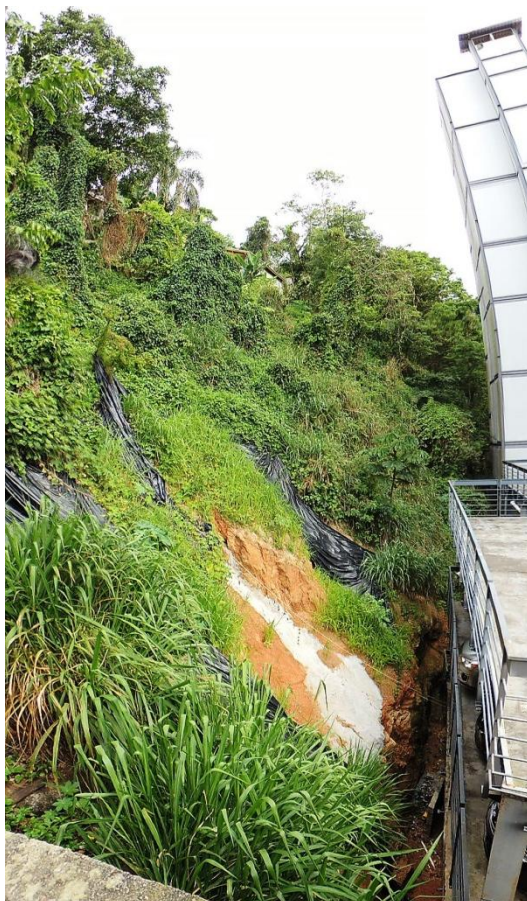
Figura 77: Visão geral do afloramento. Clínica Baía Sul à direita e a menos de um metro de distância da encosta.
