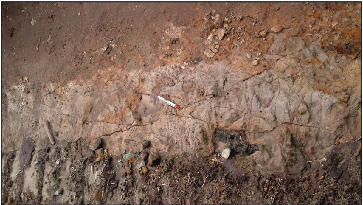
Figura 56 - Falhas de pequeno rejeito na borda oeste do domo em arenito no leito de estrada (subárea Borda-05; PLE-075).
