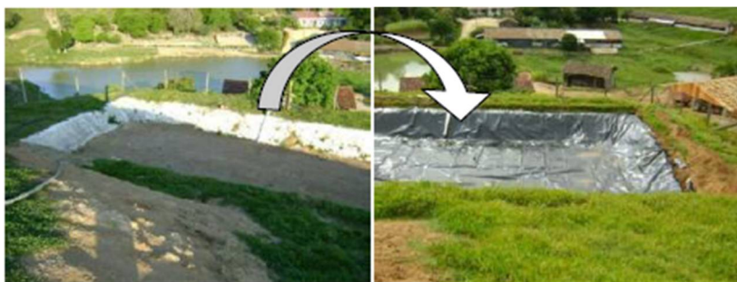
Figura 16. Readequação da lagoa de lemnas 1. Fonte: Mohedano (2010).
