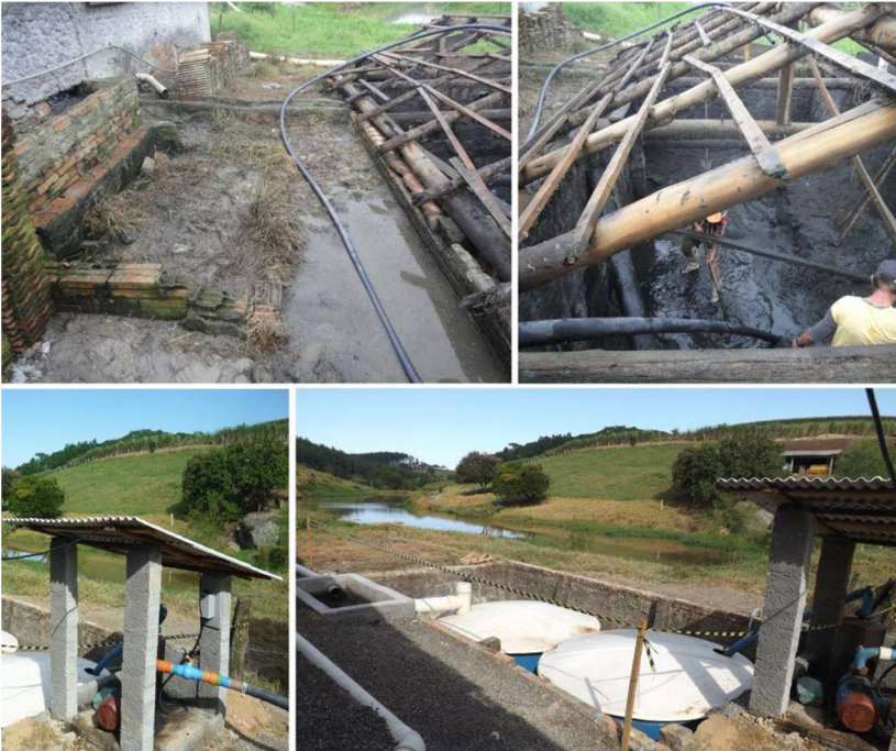
Figura 18. Reforma da Unidade de Recebimento e Bombeamento. Fonte: Arquivo TSGA.
