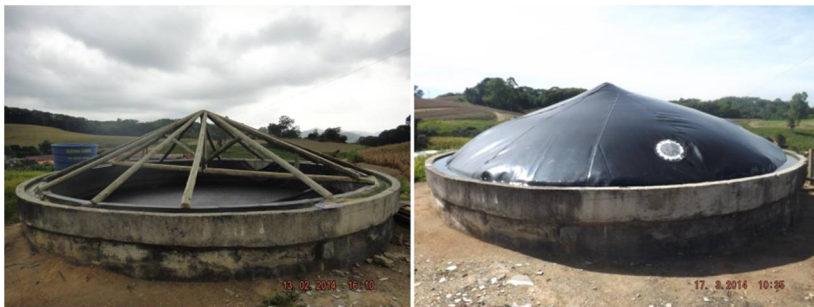
Figura 19. Recuperação do Biodigestor. Fonte: Arquivo TSGA.
