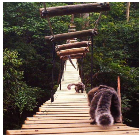
Figura 2 – Passagem aérea de fauna instalada no Condomínio Sítio Anhanguera em São Paulo
