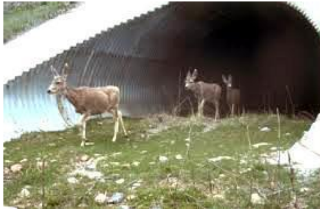
Figura 3 – Passagem inferior de fauna em Utah/USA
