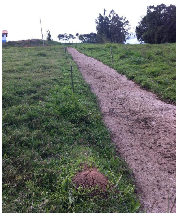
Anexo 3. Corredor de cimento até a sala evitando acúmulo de barro, e aumentando sanidade e a eficiência de locomoção dos animais.
