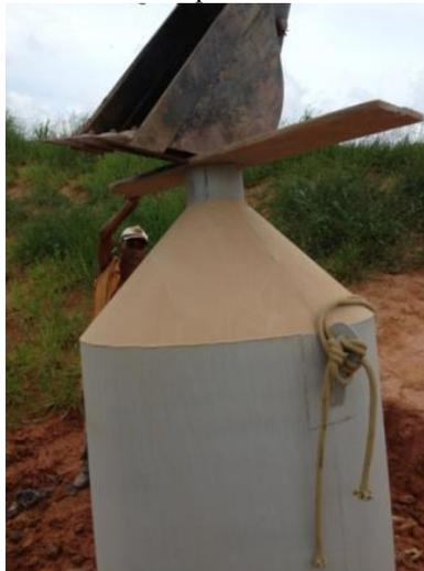
Colocação do bocal: após a colocação da campânula, era acoplado o bocal de fibra e PVC.
