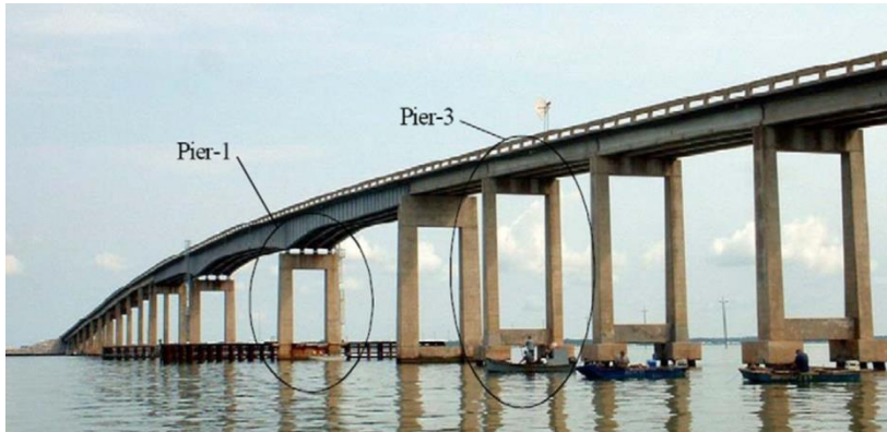
Figura 3.20 – Localização dos pilares a serem ensaiados
