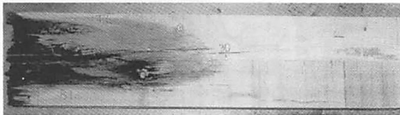
Figura 3.7 – Corte paralelo às fibras longitudinais para exibir a deterioração
