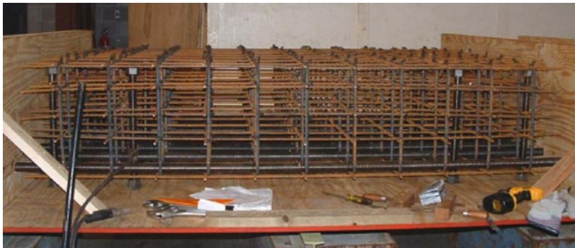
Figura 3.21 – Construção do bloco de impacto
