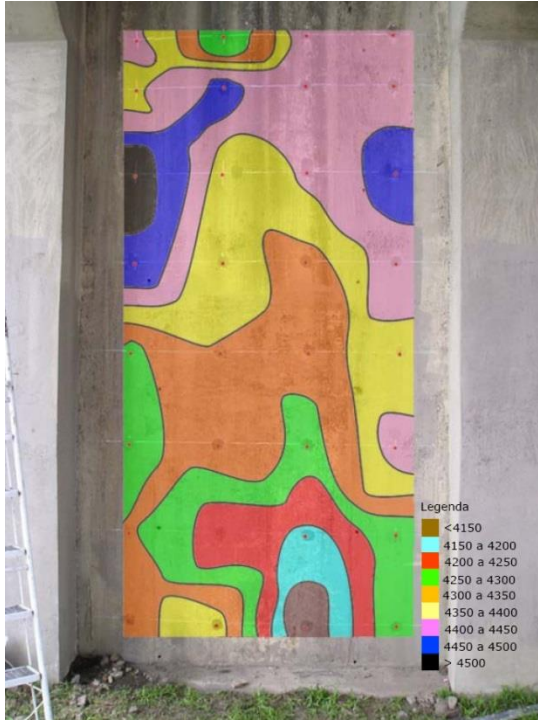
Figura 3.1 – Exibição do pilar com as curvas de velocidade (m/s) obtidas nas leituras ultrassônicas
