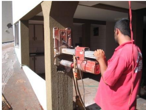
Figura 1.1 – Extração de testemunho
