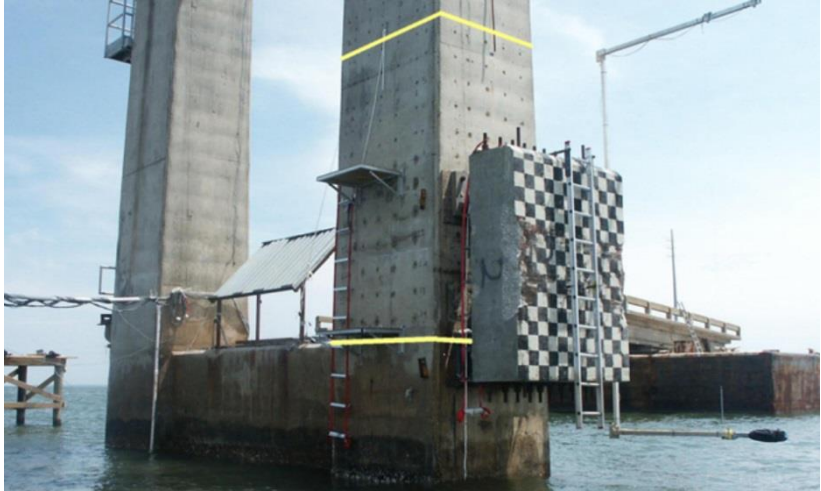
Figura 3.22 – Instalação do bloco de impacto Fonte: Ferraro, Boyd, Consolazio (2013)
