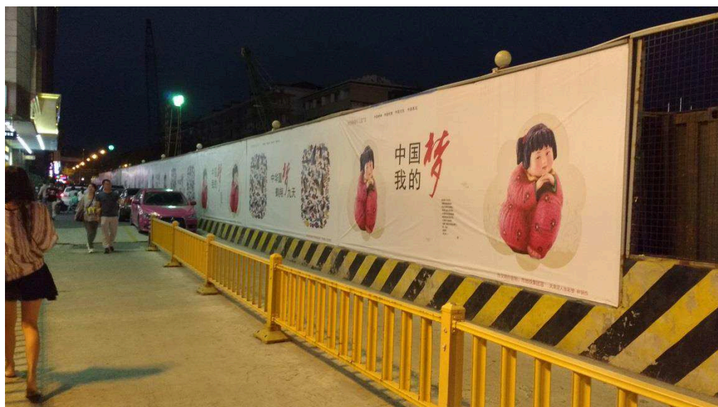
Fotografia 1 – Outdoors do “Chinese Dream” em obra do metrô da cidade de Hangzhou, província de Zhejiang.
