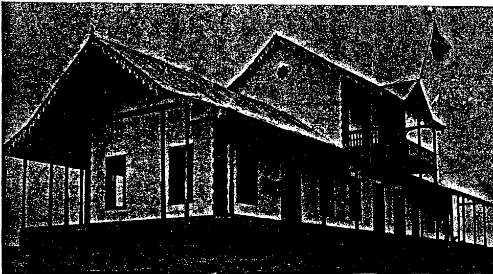
Antiga sede da Prefeitura do Departamento do Alto Juruá, ocupada atualmente pelo Fórum Municipal de Cruzeiro do Sul. Este prédio era o símbolo do poder Federal sobre a região. 101
