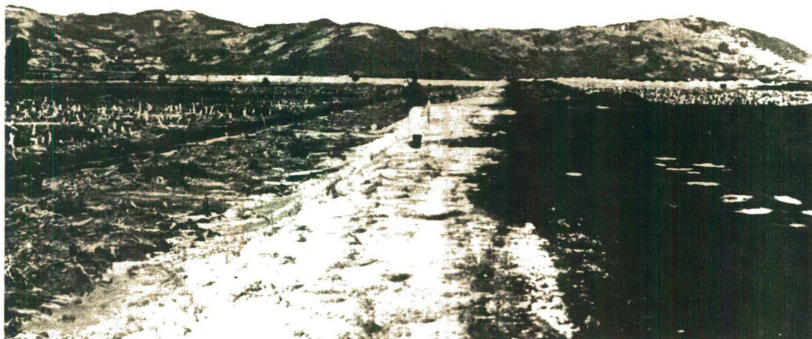
Foto 12 - Detalhe do dique construído com a cinza oriunda das Usinas Termelétricas e recoberto com argila. À esquerda, o córrego dos Matutos que teve seu curso canalizado e desviado para fora do dique.
