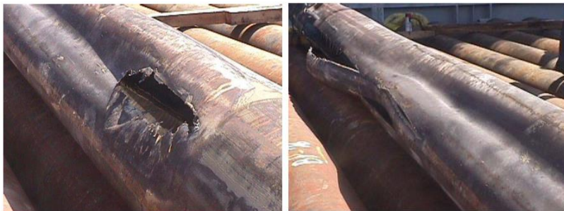
Figura 2. Tubos de revestimento após ocorrência do colapso por APB (Pattillo et al., 2004).
