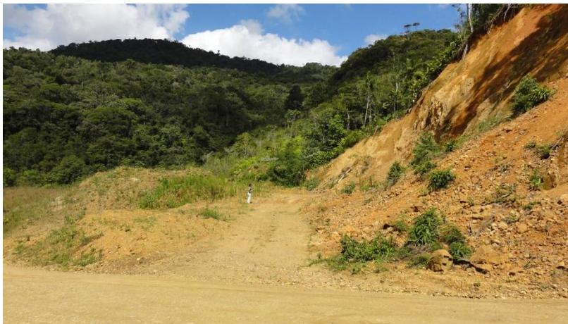
Prancha 31a: cicatriz deslizamento, talude de corte de estrada, blocos rolados
