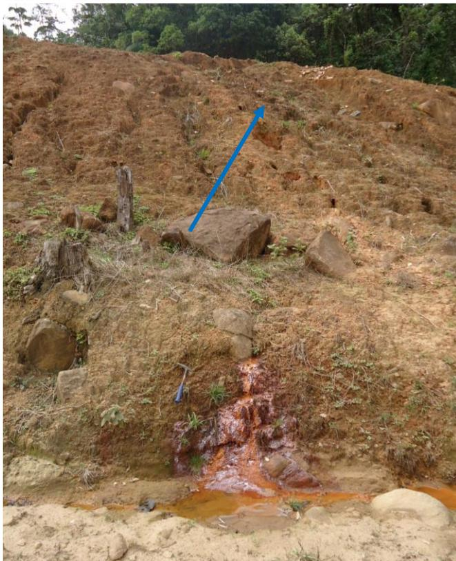
Prancha 9 Pipin, olho d'água vertendo pelo talude.
