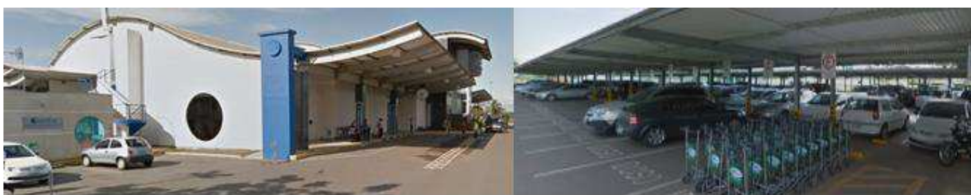
Figura 16 – Estacionamento coberto e terminal de passageiros do aeroporto de Joinville
