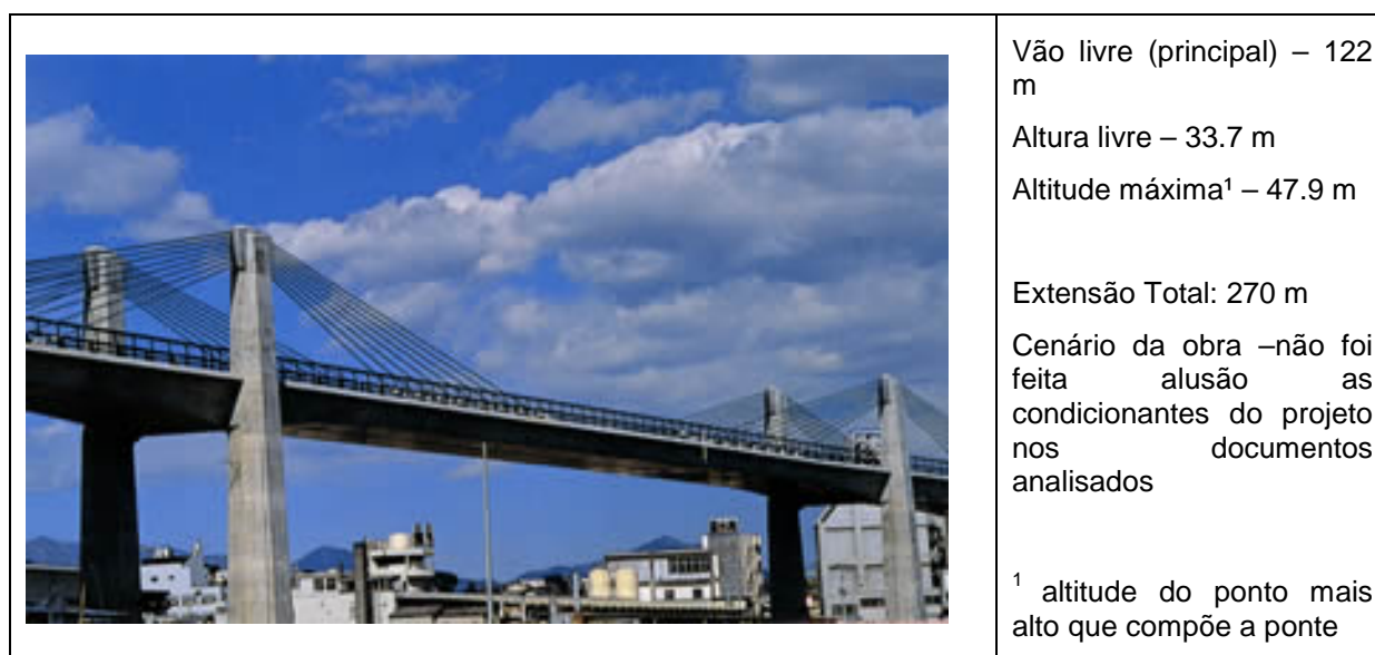
Figura 23 - Ponte Odawara Blueway
