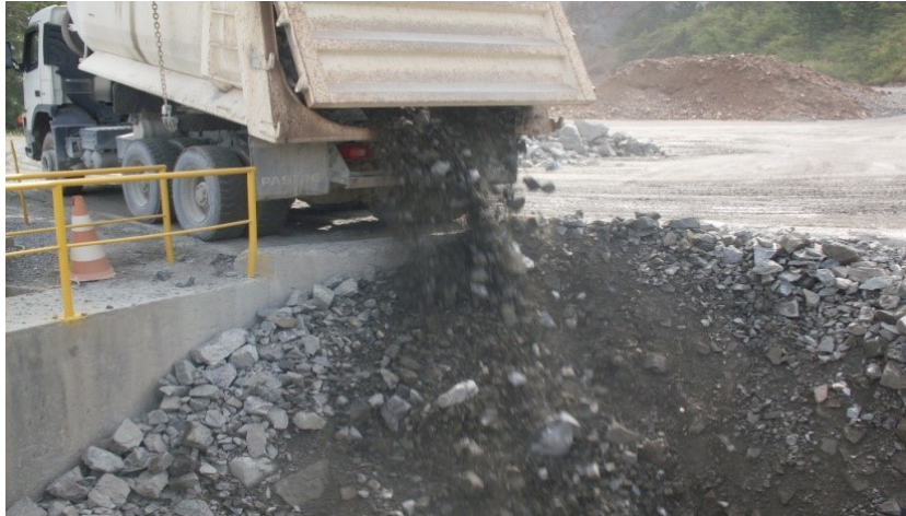
Figura 4.11 – Abastecimento do britador primário.
