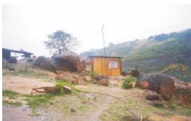
Figura 14 – Situação de risco de rolamento
