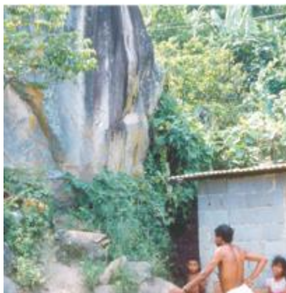
Figura 13 – Situação de risco de tombamento
