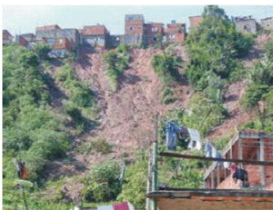
Figura 5 – Escorregamento planar induzido pela ocupação indevida
