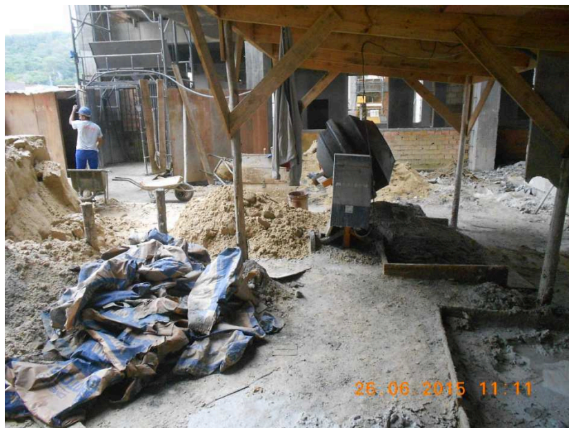
Figura 13 - Central de argamassa
