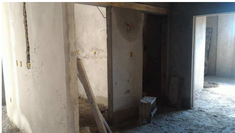
Figura 19 - Execução de reboco no 5º pavimento do Bloco FG
