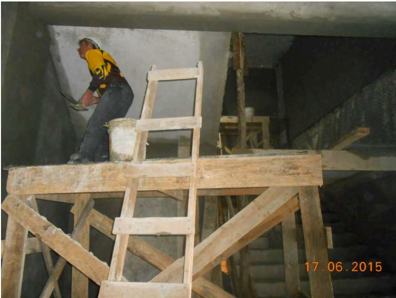
Figura 17 - Execução de reboco no térreo do Bloco Acesso G
