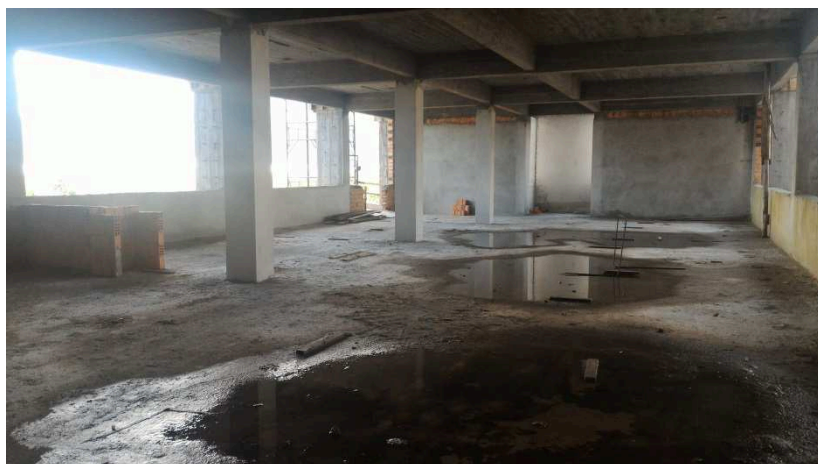
Figura 18 - Serviço de reboco finalizado no 5º Pavimento do Bloco G
