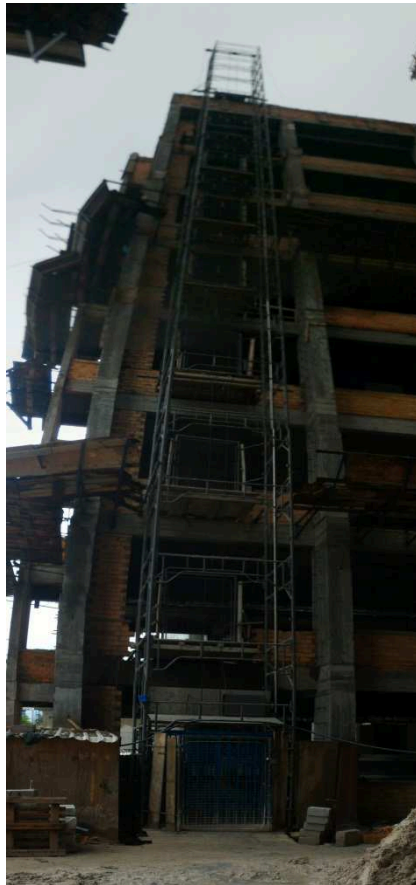
Figura 12 - Elevadores provisórios para transporte de materiais
