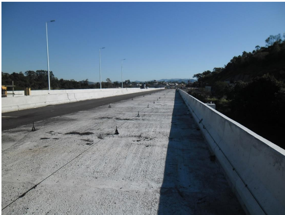
Foto 22 - Vista geral da praça de trabalho.
