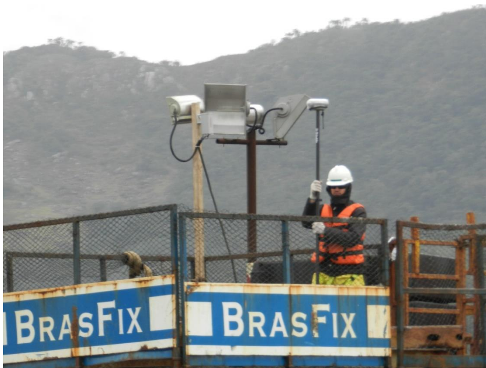
Foto 13 - Operação com GNSS para locação das estacas.
