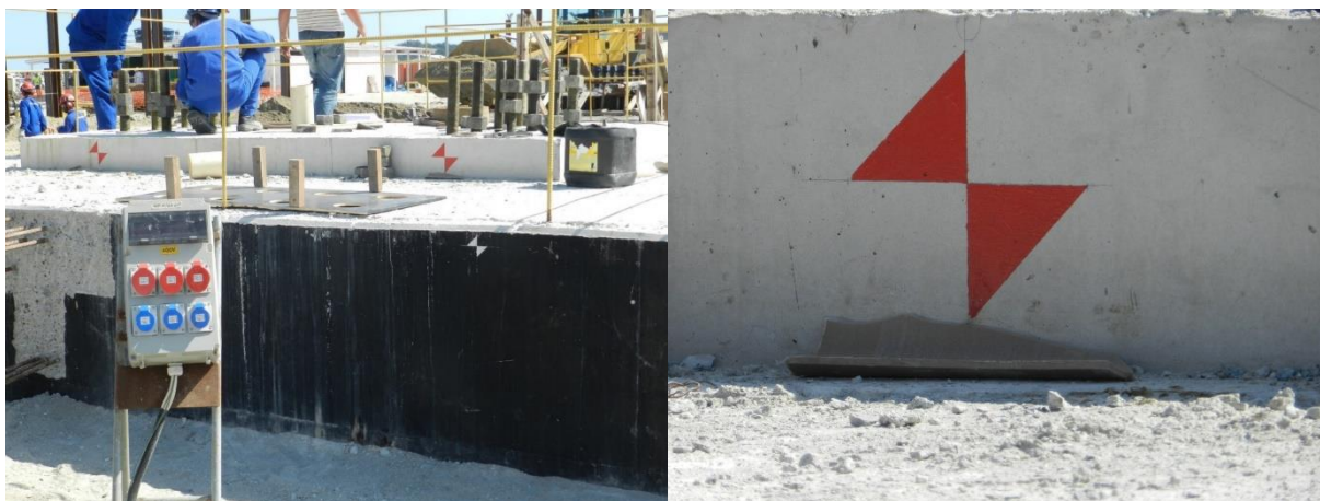
Foto 4- Marcação em obra por meio da pintura de bandeirolas.
