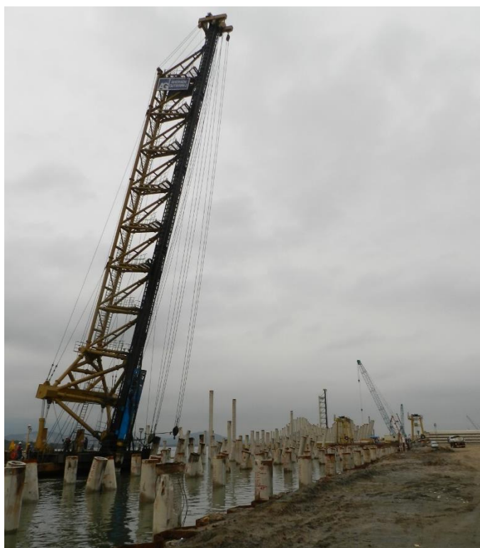
Foto 6- Execução de estaqueamento em Santos/SP.
