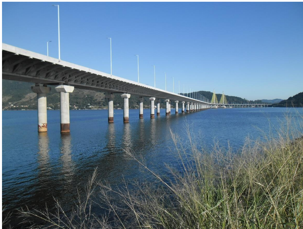
Foto 7 - Aspecto geral da Ponte Anita Garibaldi.
