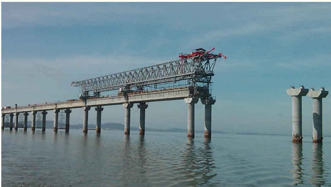
Foto 14 - Treliça lançadora durante montagem das aduelas de concreto.
