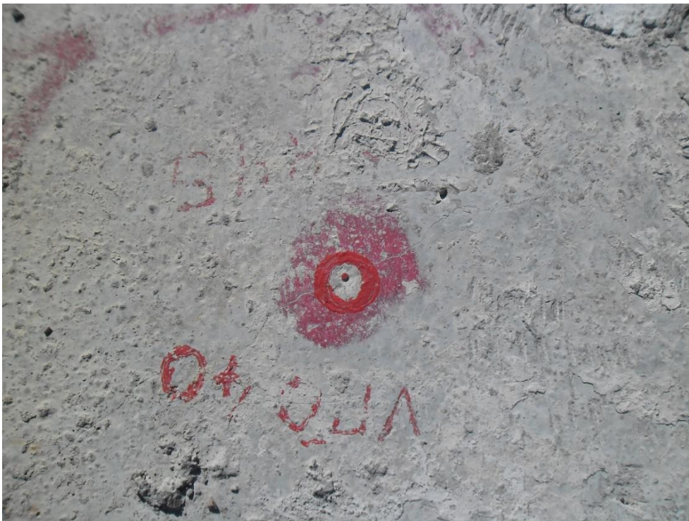
Foto 15 - Pino metálico utilizado na locação das aduelas de concreto.
