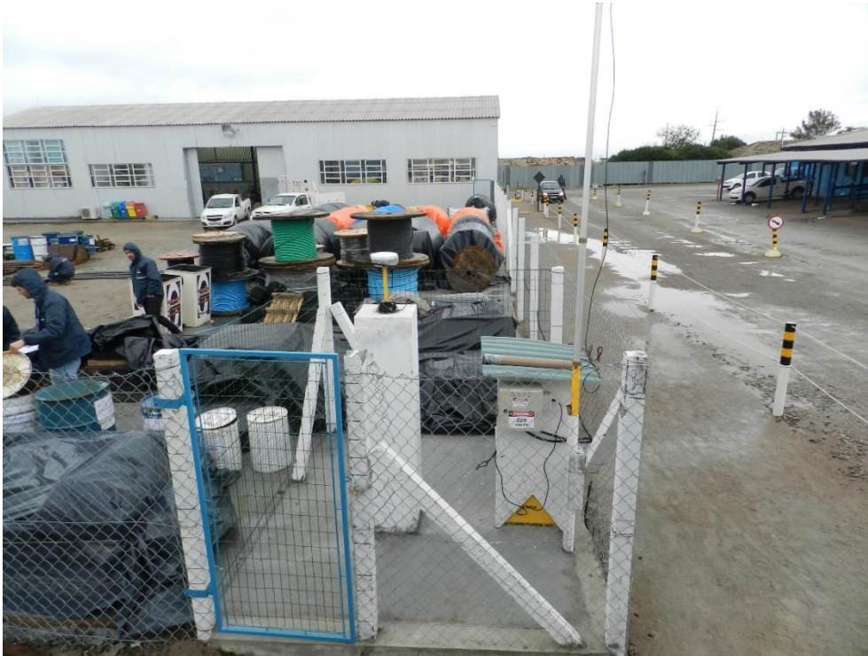
Foto 8 - Equipamento GNSS instalado no Marco Base e conectado ao rádio UHF.
