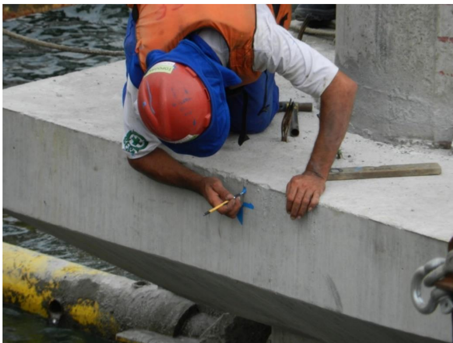
Foto 3- Marcação em obra por meio da pintura de bandeirolas.
