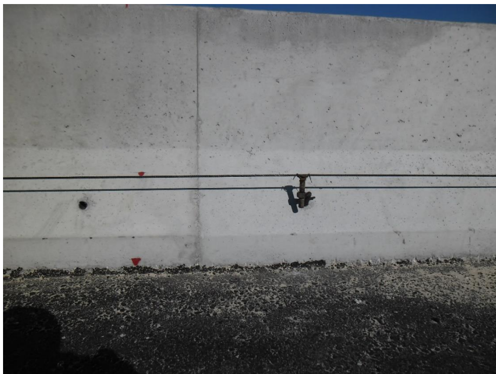
Foto 19 - Marcação dos níveis e fixação dos cabos na mureta New Jersey .
