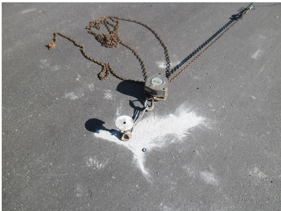
Foto 20 - Fixação e tensionamento dos cabos com auxílio de talha.
