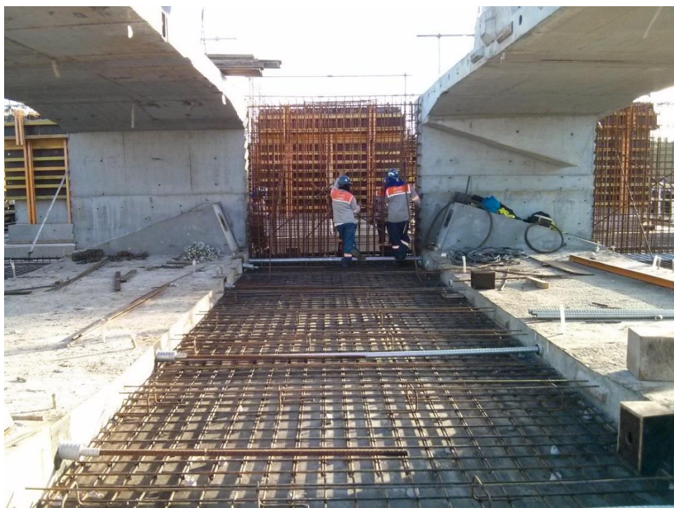
Foto 16 - Construção das aduelas "face a face".
