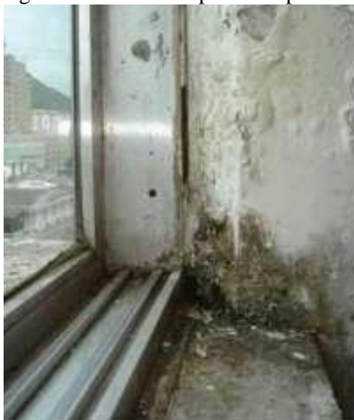
Figura 20 – Manchas pretas na parte inferior da janela interna.
