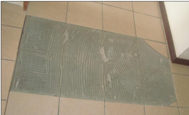
Figura 46 – Manifestação R1: Descolamento de pisos.
