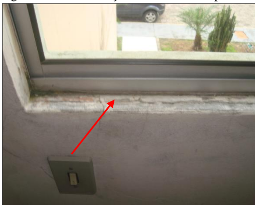
Figura 35 – Manifestação F12: Fissura no peitoril.
