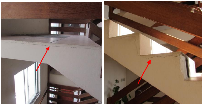
Figura 33 – Manifestação F10: Fissura entre contrapiso e argamassa de assentamento.
