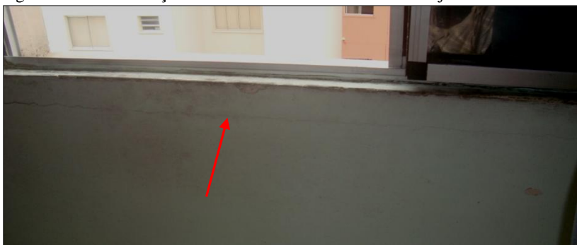
Figura 24 – Manifestação F1: Fissura horizontal embaixo da janela.
