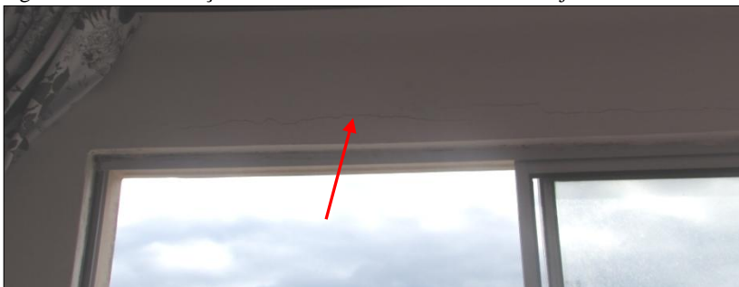
Figura 26 – Manifestação F5: Fissura horizontal em cima da janela.
