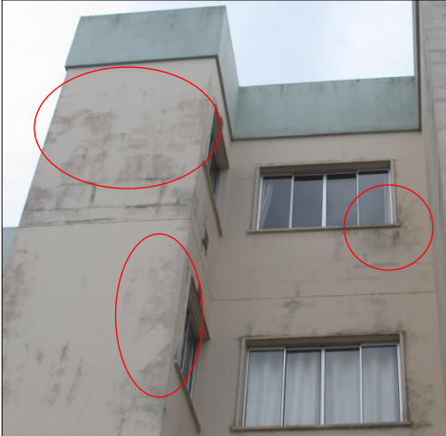
Figura 45 – Manifestação M4: Mancha escura na fachada.
