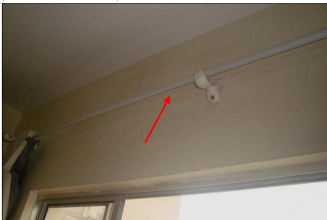
Figura 37 – Manifestação F14: Fissura na interface alvenaria estrutural/laje (Levantamento interno).
