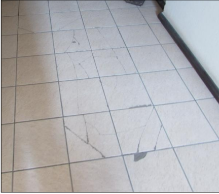
Figura 34 – Manifestação R2: Rachadura no revestimento cerâmico.
