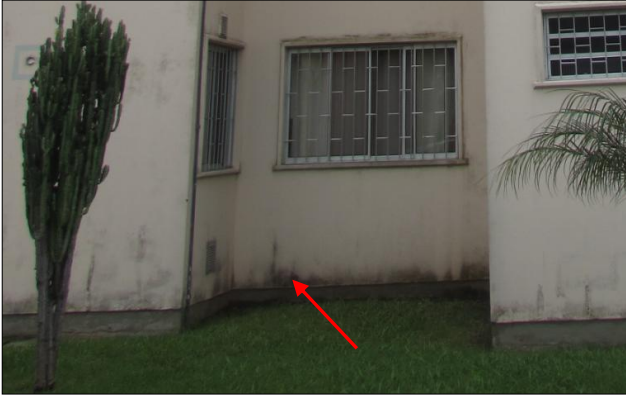
Figura 41 – Manifestação M3: Mancha escura na viga de baldrame.
