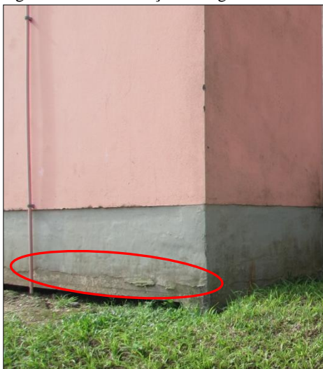
Figura 42 – Deterioração da viga de baldrame.
