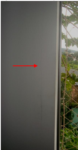
Figura 25 – Manifestação F2: Fissura vertical ao lado da janela.
