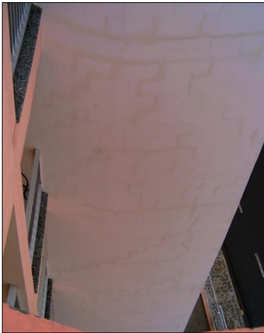
Figura 44 – Fissuração da argamassa acompanhando as juntas de assentamento da alvenaria.
