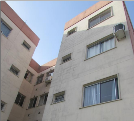
Figura 43 – Manifestação FM: Fissura na fachada mapeada por manchas escuras.
