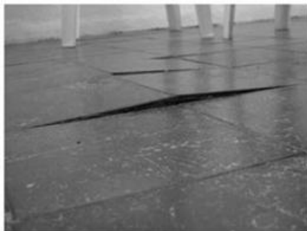
Figura 18 – Destacamento de piso cerâmico.
