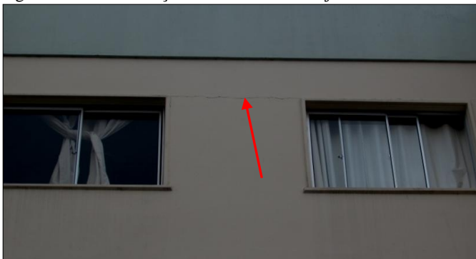
Figura 36 – Manifestação F13: Fissura entre janelas.
