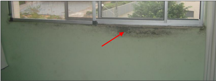
Figura 39 – Manifestação M1: Mancha escura em parede.
