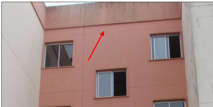
Figura 38 – Manifestação F14: Fissura na interface alvenaria estrutural/laje (Levantamento externo).
