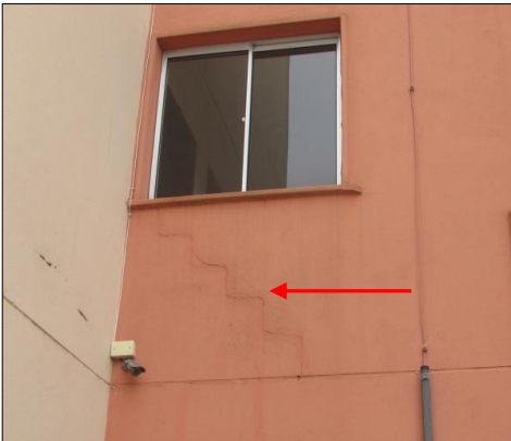
Figura 30 – Manifestação F9: Fissura escalonada.
