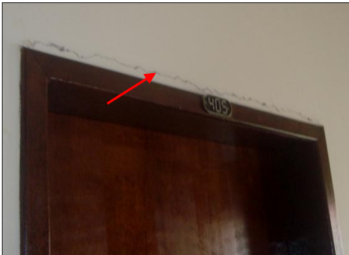
Figura 27 – Manifestação F3: Fissura horizontal sobre a porta.
