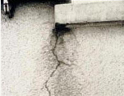
Figura 7 – Acúmulo de água em borda de peitoril propicia a formação de fungos.
