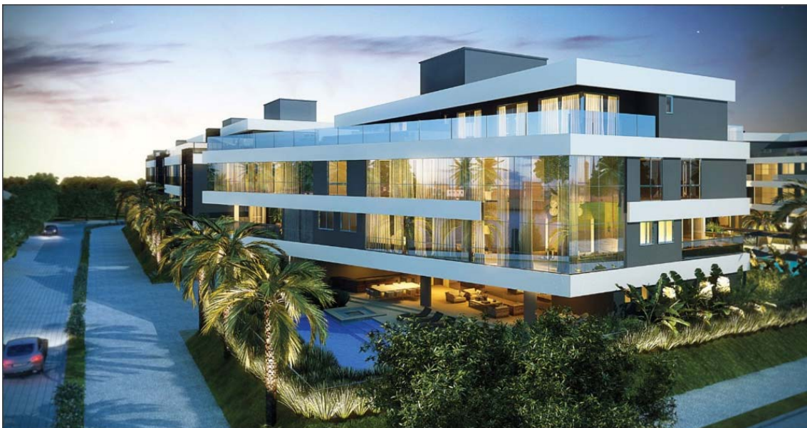
Figura 10 - Obra estudada. Fonte: Empresa.
