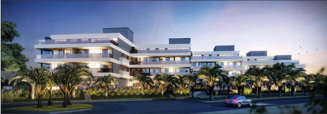
Figura 11 - Obra estudada. Fonte: Empresa.
