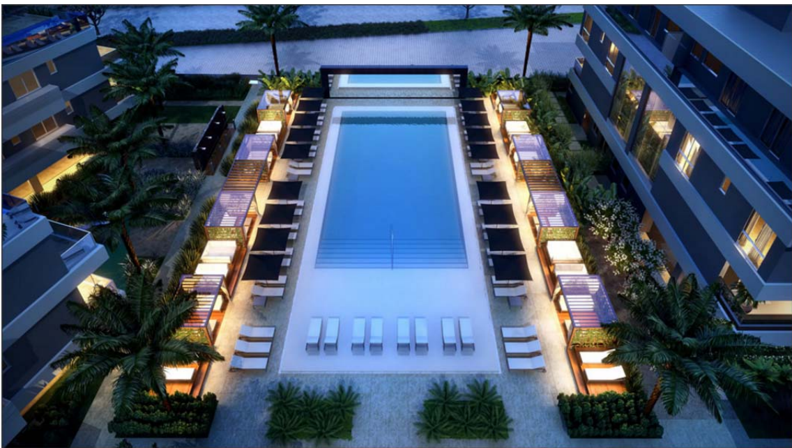
Figura 12 - Obra estudada. Fonte: Empresa.
