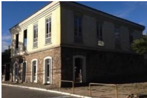
Figura 52- Edificação colonial revitalizada e localizada na Praça Roldão da Rocha Pires, Santo Antônio de Lisboa.
