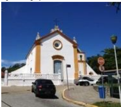
Figura 3- Igreja de Nossa Senhora das Necessidades, Santo Antônio de Lisboa.
