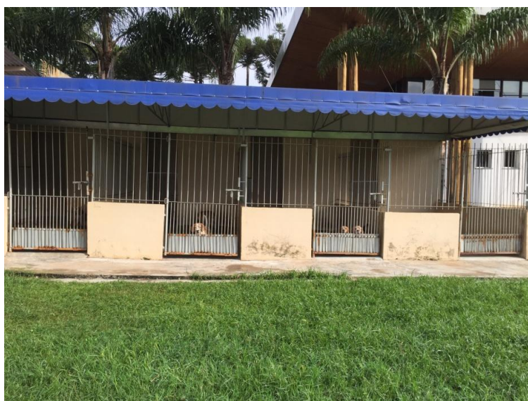
Figura 3 - Baias de alvenaria
