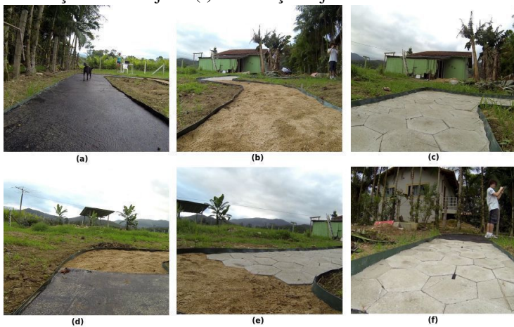
Figura 55 – (a) Asfalto. (b) Terra. (c) Lajota. (d) Intersecção asfalto e terra. (e) Intersecção terra e lajota. (f) Intersecção lajota e asfalto.
