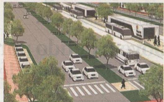
Serão projetadas três pistas para veículos e uma para ônibus em cada sentido
