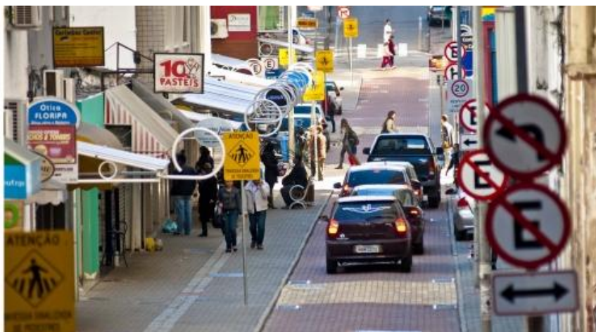
Foto: Rua Vidal Ramos após as obras
