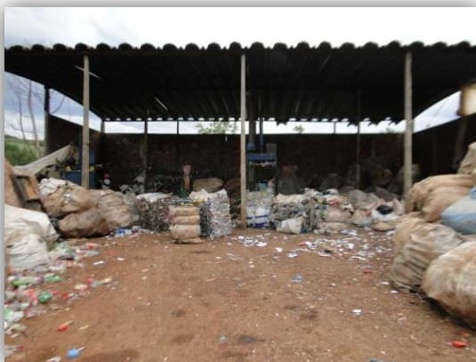
Figura 37 - Barracão de separação e prensa de materiais recicláveis (bairro Bom Pastor)
