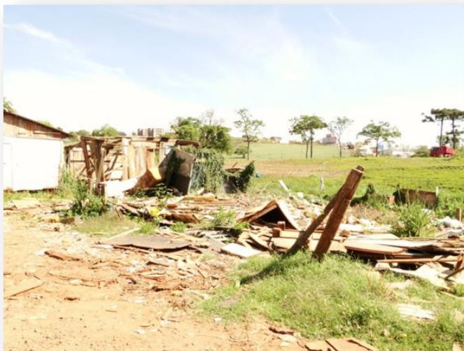
Figura 21- Restos de barracos demolidos em área de ocupação (bairro Bom Pastor)
