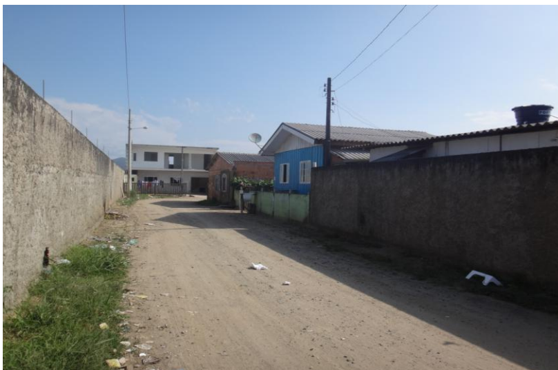
Figura 24 - Rua Lizânia Araújo Coelho – diversidade de padrão construtivo
