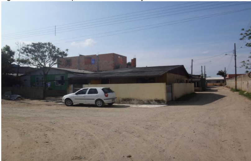
Figura 20 – Rua Roque Borba – construção nova
