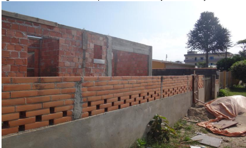
Figura 19 – Foto da Rua Roque Bernardino Gaya – construção nova
