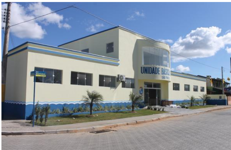
Figura 14 – Unidade Básica de Saúde do Bairro São Paulo, Navegantes - SC
