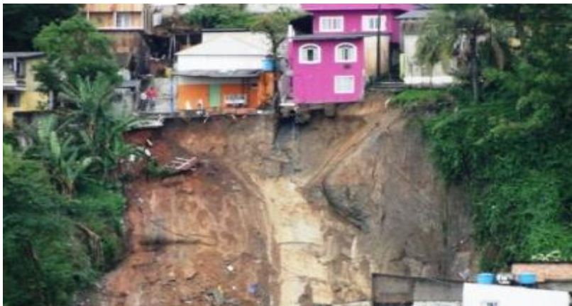
Figura 10 – Deslizamento no Morro da Mariquinha – Florianópolis/SC. Dezembro de 2011.
