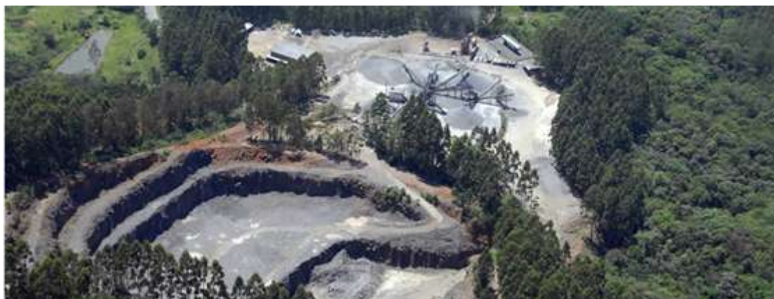
Figura 3.1 - Britagem Rio Maior – Urussanga/SC.
