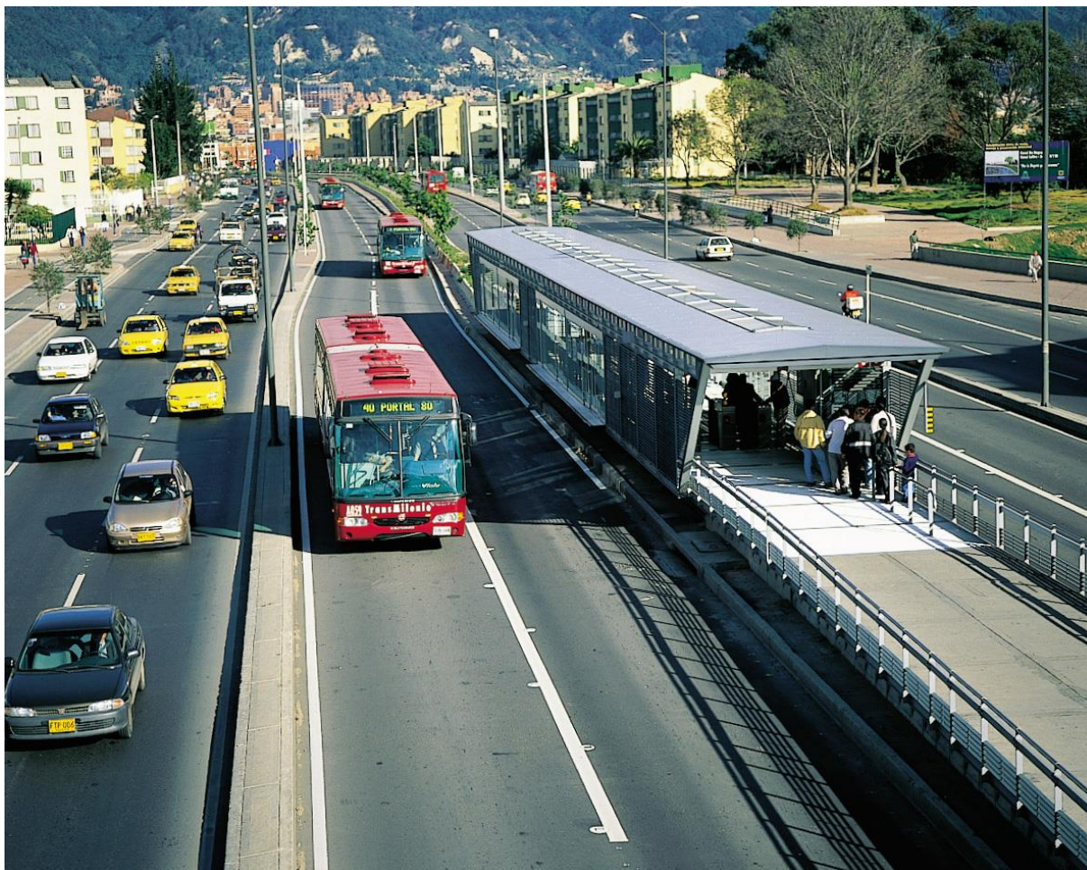
Figura 6 - BRT em Bogotá, Colômbia.
