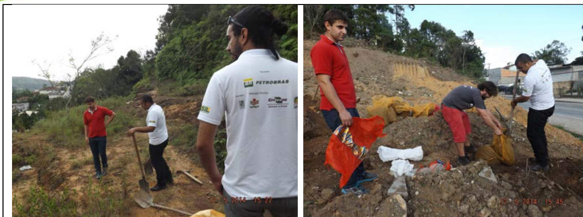
Imagens 126 e 127 - Reconhecimento da área e preparação dos sacos de contenção.
