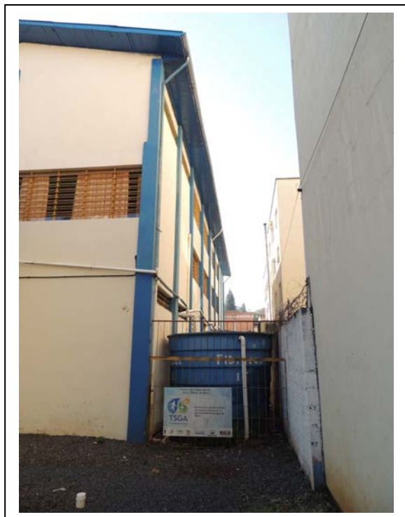
Foto 1: Cisterna Instalada na Escola Educação Básica Deodoro durante TSGA I.
