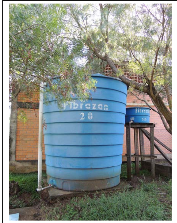
Foto 2: Cisterna Instalada na Escola Municipal no Distrito de Planalto durante TSGA I.
