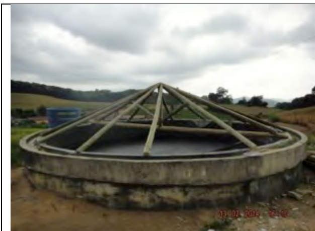
Imagem 51 - Estrutura de madeira no biodigestor.
