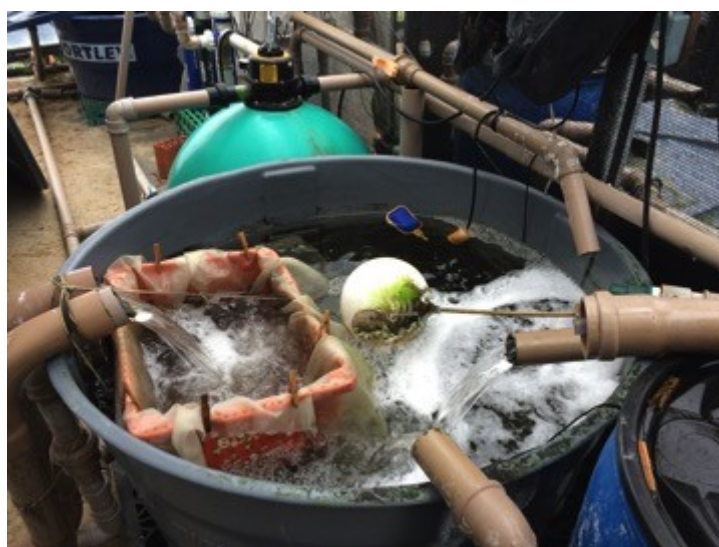
Figura 6 - Sump, e primeiro filtro físico (tela de 300 \mu\text{m} ), com filtro de areia e UV ao fundo.
