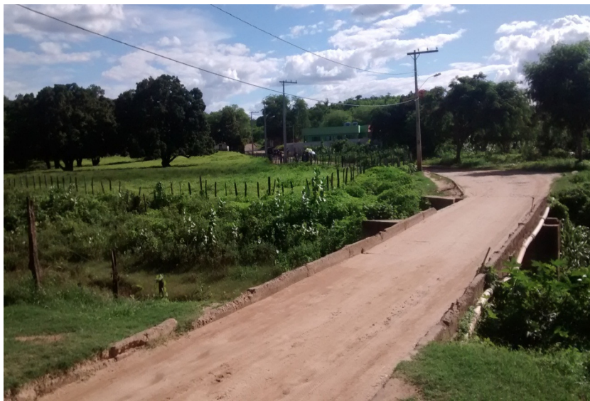
Figura 3 - Ponte de Acesso ao Bairro Lazaredo
