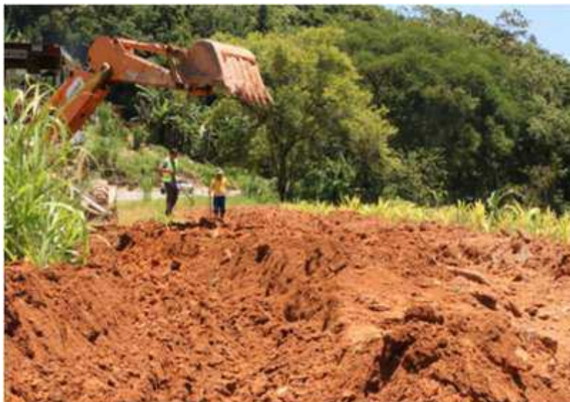
Figura 6. Recondicionamento do solo de Bota-fora. Fonte: IÇARA. Data: Fevereiro de 2014.
