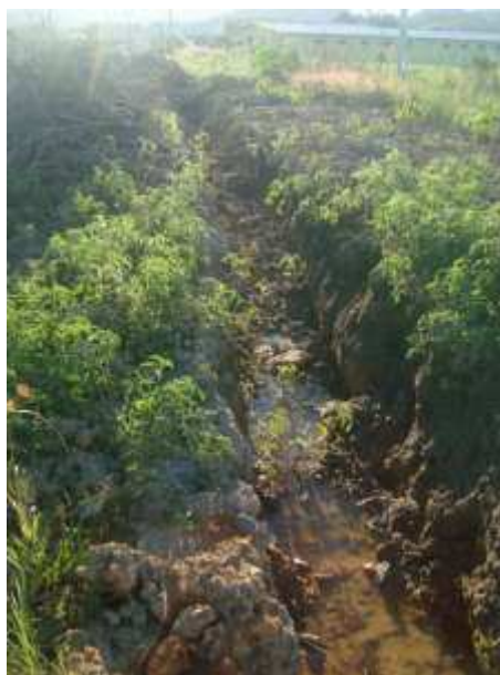
Figura 22. Retenção de água no canal de infiltração. Fonte: Gabriel Souza. Data: Maio de 2014.
