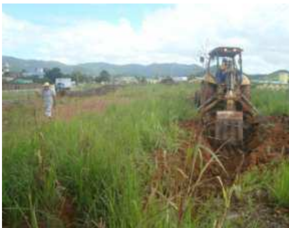
Figura 18. Início de abertura de mais uma canal de infiltração. Fonte: Gabriel Souza. Data: Abril de 2014.
