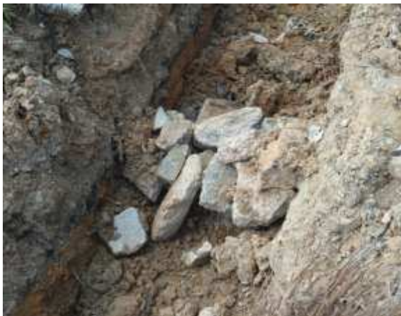
Figura 20. Deposição de pedras para auxílio de retenção de água, ao longo dos canais de infiltração. Fonte: Gabriel Souza. Data: Abril de 2014.
