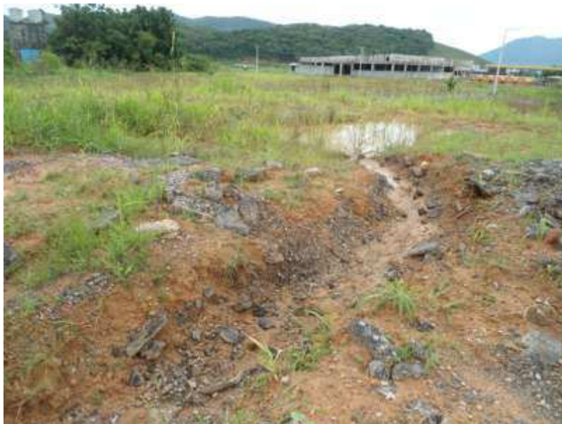
Figura 17. Bacia de contenção. Fonte: IÇARA. Data: Março de 2014.
