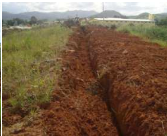
Figura 19. Abertura de mais uma canal de infiltração. Fonte: Gabriel Souza. Data: Abril de 2014.
