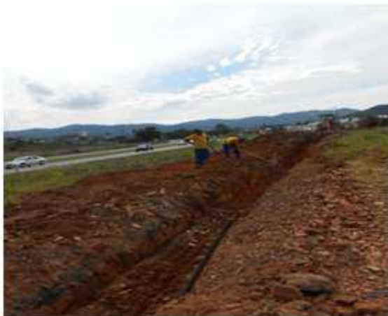
Figura 7. Canal de infiltração e retenção de umidade. Fonte: IÇARA. Data: Fevereiro de 2014.
