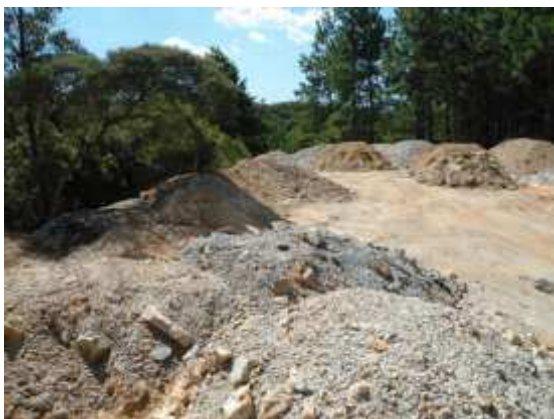
Figura 2. Área de deposição de material. "Bota-fora". Fonte: IÇARA. Data: Fevereiro de 2014.
