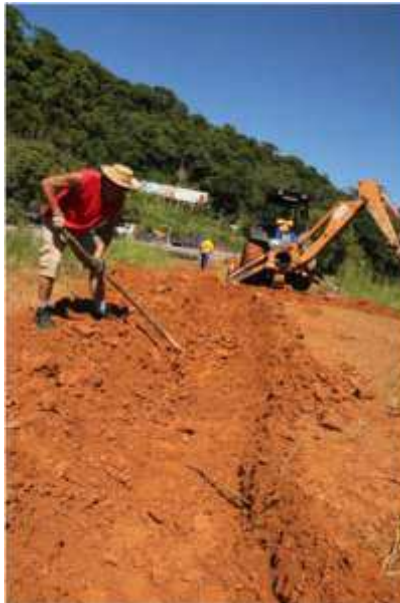
Figura 9. Descompactação do solo. Fonte: IÇARA. Data: Fevereiro de 2014.
