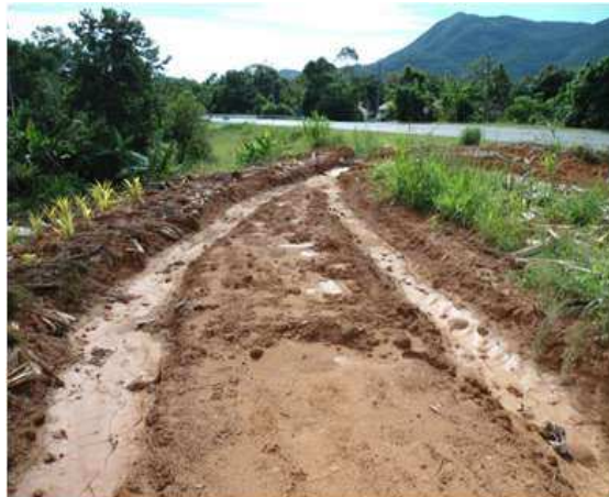
Figura 8. Vala de drenagem. Fonte: IÇARA. Data: Fevereiro de 2014.
