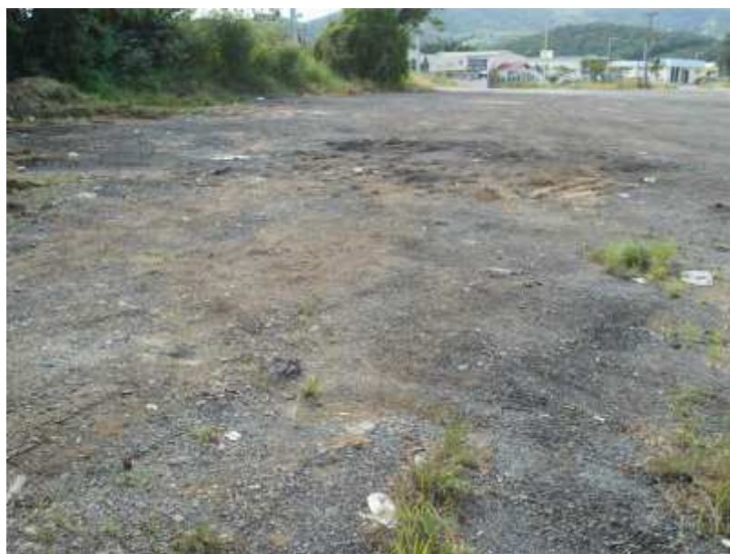
Figura 23. Bota-fora 2 com solo asfaltado. Fonte: IÇARA. Data: Abril de 2014.
