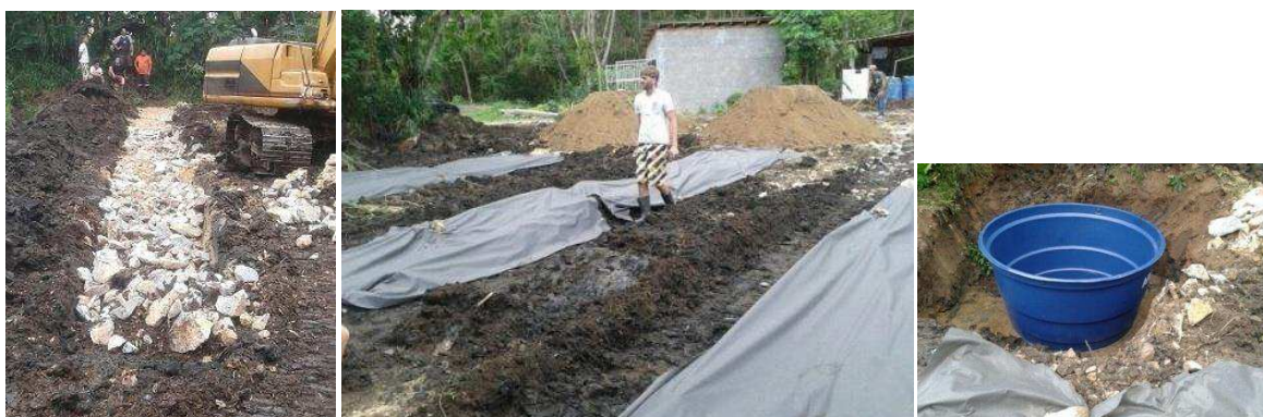
Figuras 36. a) Presença de cascalho em vala aberta no Pátio UFSC. b) Manta geotérmica e montes de areia. c) Caixa coletora do líquido percolado das leiras.
