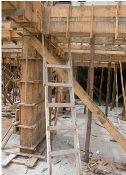
Figura 3- Emprego da madeira(esq.) na obra para execução de formas e painéis de vedação na área de apoio da obra(dir.). HNS, 2006.
