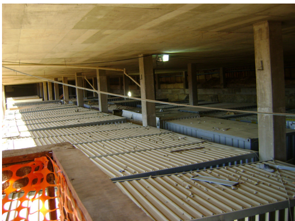
Figura 5- Canteiro de obras da construtora W Torre em São Paulo. Uso massivo de container como barraco de obra das subempreiteiras. HNS, 2008.
