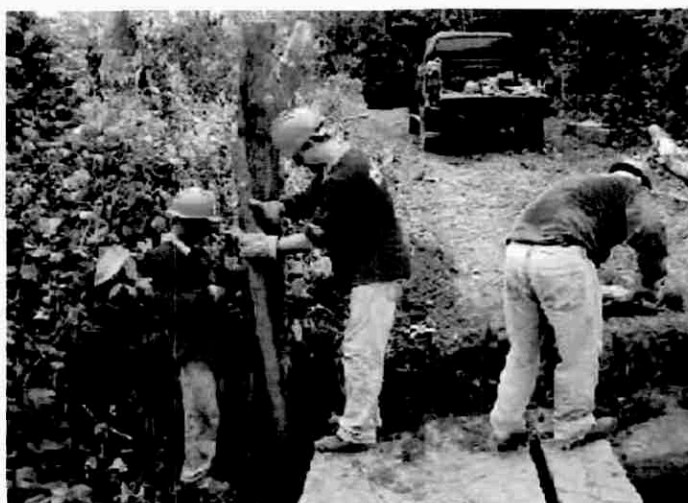
Figura 04: Manutenção de caminhos e acessos Fonte: Cotesa, 2006.
