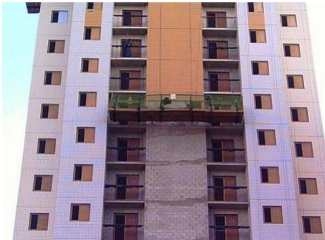
**Figura 2-** Exemplo de aplicação de revestimento cerâmico direto sobre o bloco de concreto (Fonte: DARINI, 2006).
