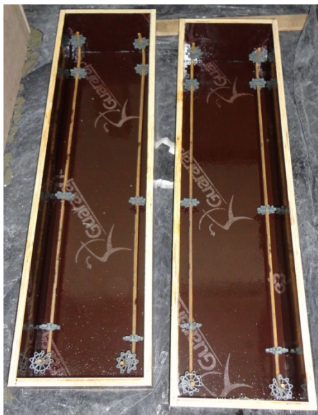
Figura 4.5: Formas e armaduras das vigas
