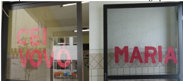
Foto 4 - Porta de acesso ao corredor das salas dos grupos
