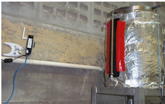
Figura 70 – Câmara web e nível do reservatório.
