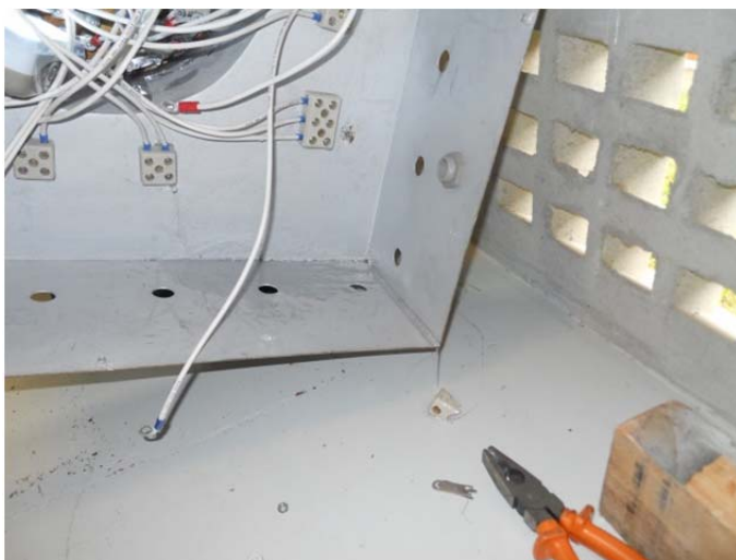
Figura 56 – Vazamento apresentado no aquecedor de 200 KW (A)
