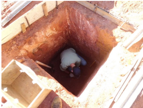
Figura 137 – Coleta de amostra no Poço de Inspeção
