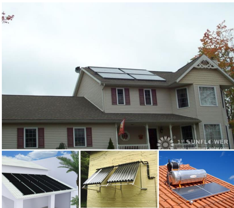
Figura 59 - Aquecedores solares sobre telhados de forma convencional.
