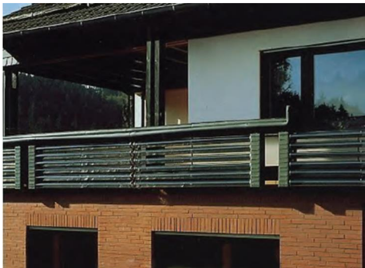
Figura 55 - Tubo de vácuo utilizado como guarda corpo em sacada.
