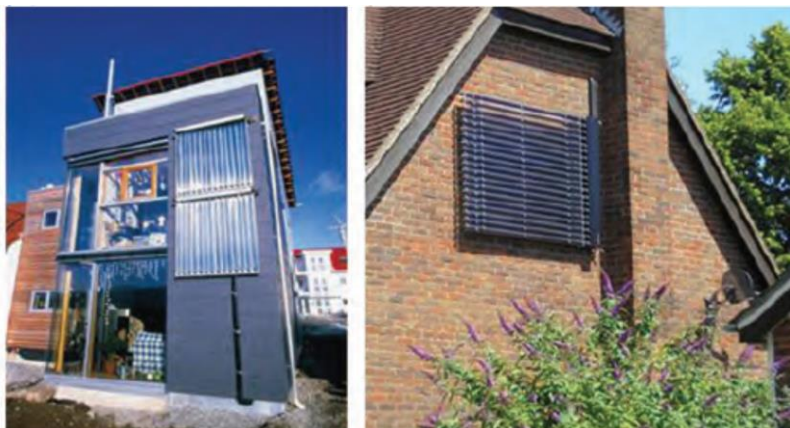
Figura 56 - Tubo de vácuo utilizado para composição em fachada e como quebra sol.
